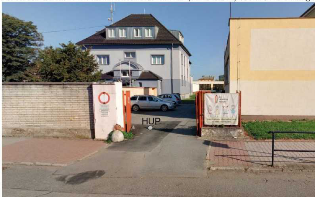
Příloha č.1 - orientační zakres umístění nové skříně HUP přisazení k objektu do barevné fotografie
