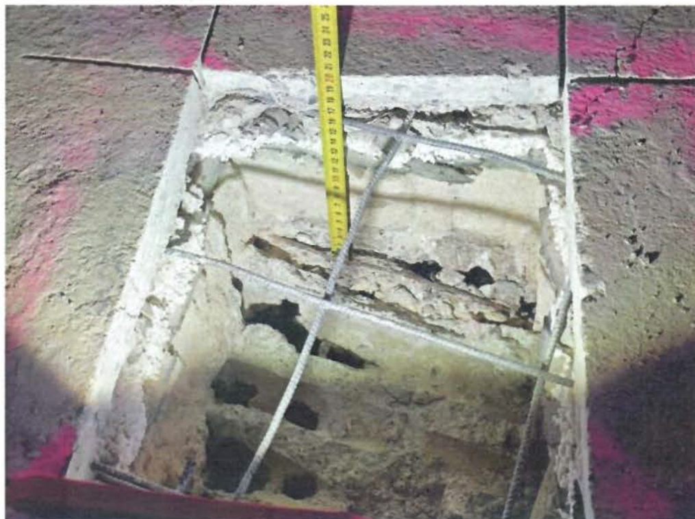
(obr. č. 1 – sonda: tělocvična)
