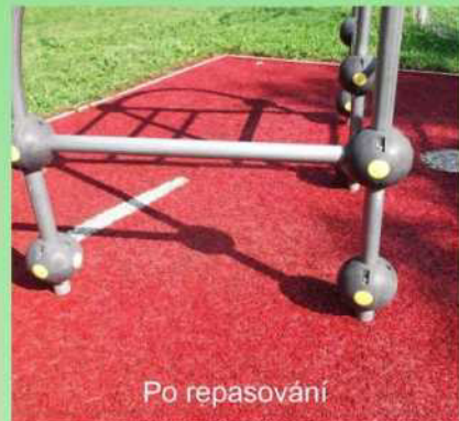
Ukázky repasovaného povrchu Softnyx (po 7 letech užívání)
