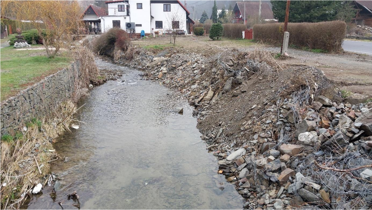
Kobylí potok km 5,600-8,225 (PŠ 2024)
