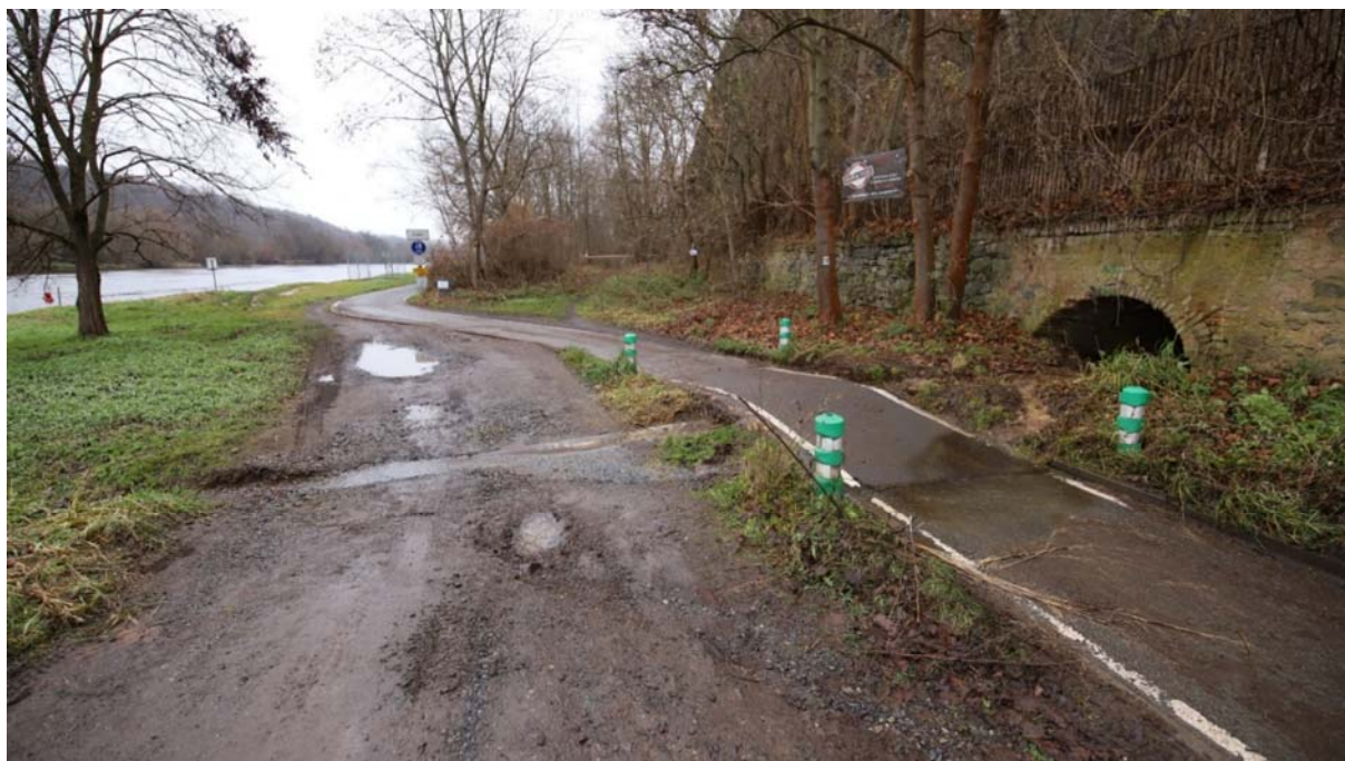
Obrázek 9: pohled na přístup na místo nezbytného zásahu po nezpevněné trase, vstup na pozemek 814 je omezen výstražnou páskou v pozadí snímku
