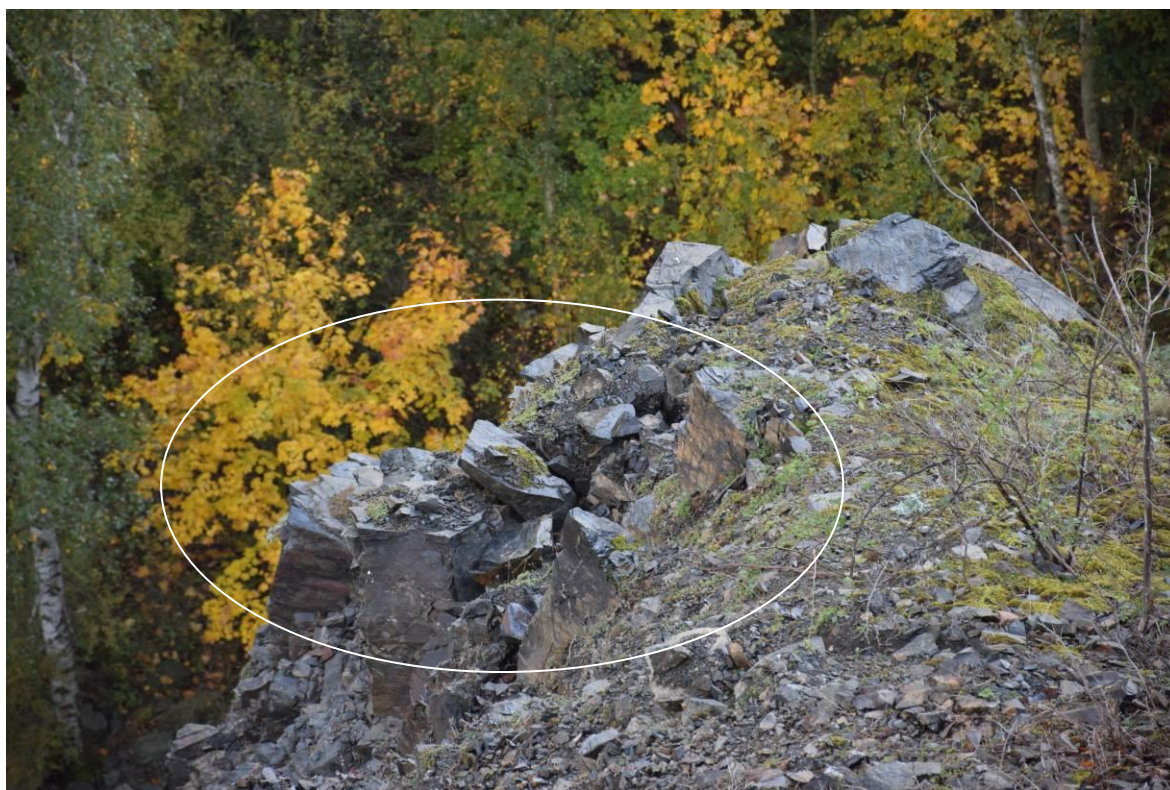
Foto 6 Ukázka dílčích nestabilních částí skalní stěny opuštěného lomu – zvýrazněno bílou elipsou . Mocnost trhlínou oddělené části lze odhadovat (fotografováno teleobjektivem) na přibližně 1 m.
