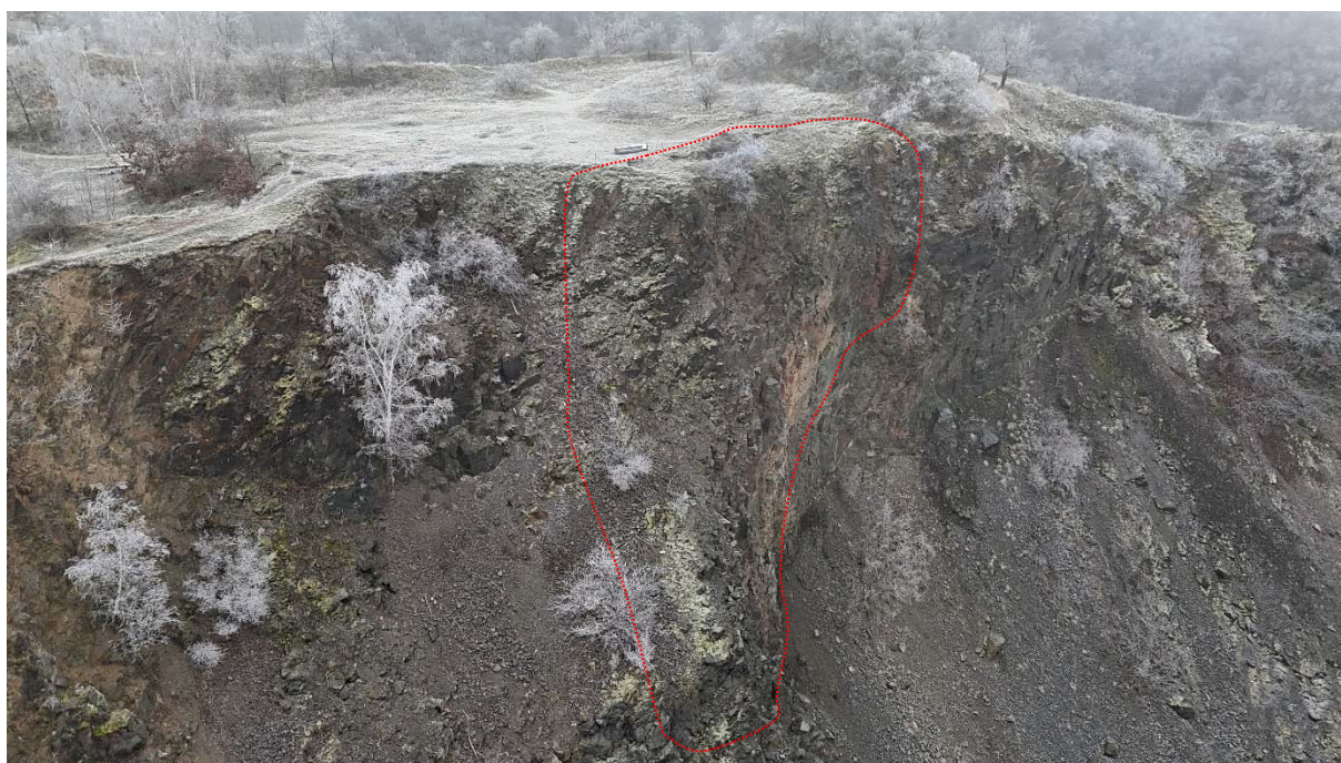
Obrázek 14: pohled na nestabilní masiv ze severu s vyznačením rozsahu nestabilního masivu, masiv v tomto rozsahu o objemu cca 840 m 3 je v procesu dlouhodobých plouživých procesů destabilizace masivu
