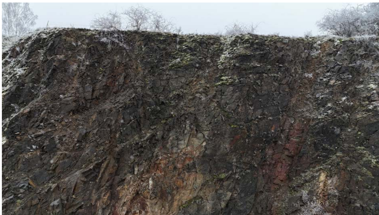
Obrázek 19: detail stavu nestabilního masivu a ploch odlučnosti v jeho horní části
