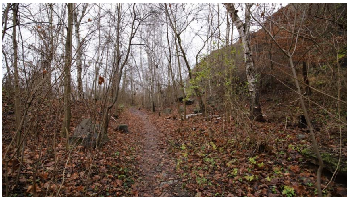
Obrázek 11: stávající povaha paty svahu, vpravo se zvedá osypový kužel, hrubé fragmenty pocházejí z horní hrany skalní stěny, hustý vegetační porost náletovými dřevinami
