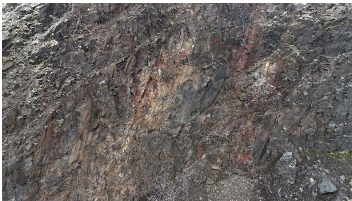
Obrázek 20: detail spodní partie nestabilního masivu se změnou systému ploch odlučnosti, dokumentovány významné posuny podél ploch odlučnosti až 6,5 cm,
