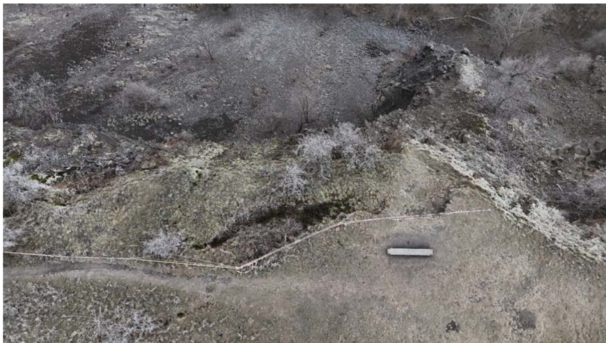
Obrázek 16: horní pohled na oblast nestabilního masivu, spodní partie svahu tvořeny strmým osypovým kuželem, oblast uzavřena na hranici otevřené hlavní trhliny, další poklesy jsou u levé spodní části snímku a náleží k celému nestabilnímu vývoji masivu
