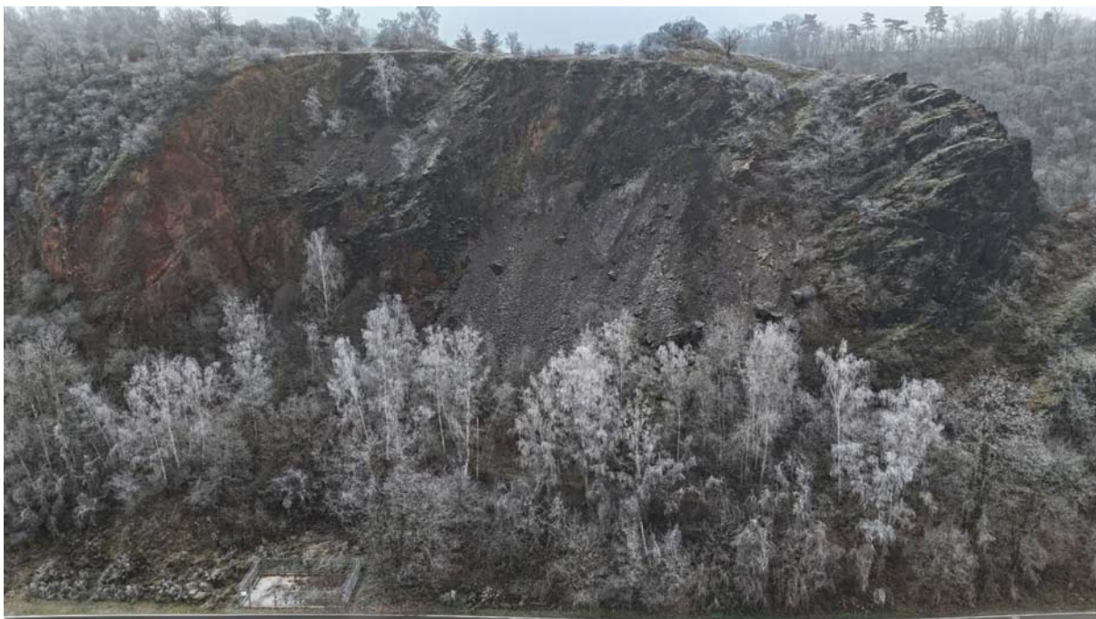
Obrázek 22: celkový pohled na oblast nezbytného havarijního zásahu v PP Zámky
