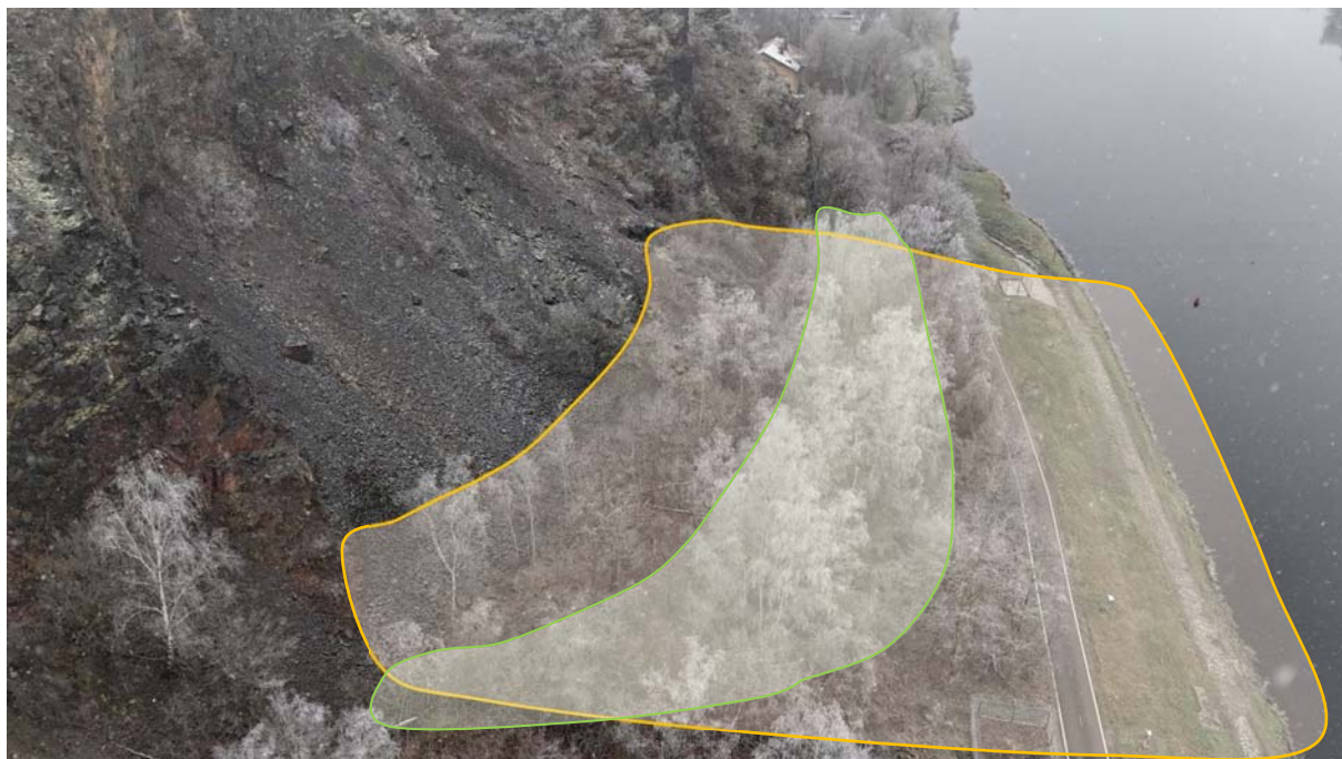
Obrázek 17: pohled na oblast přímo ohroženou projevy skalního řícení se zákresem předpokládané polohy ochranného valu v patě svahu
