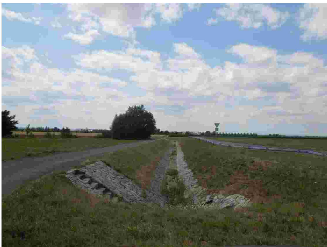
Kanál dešťových vod – východní strana
