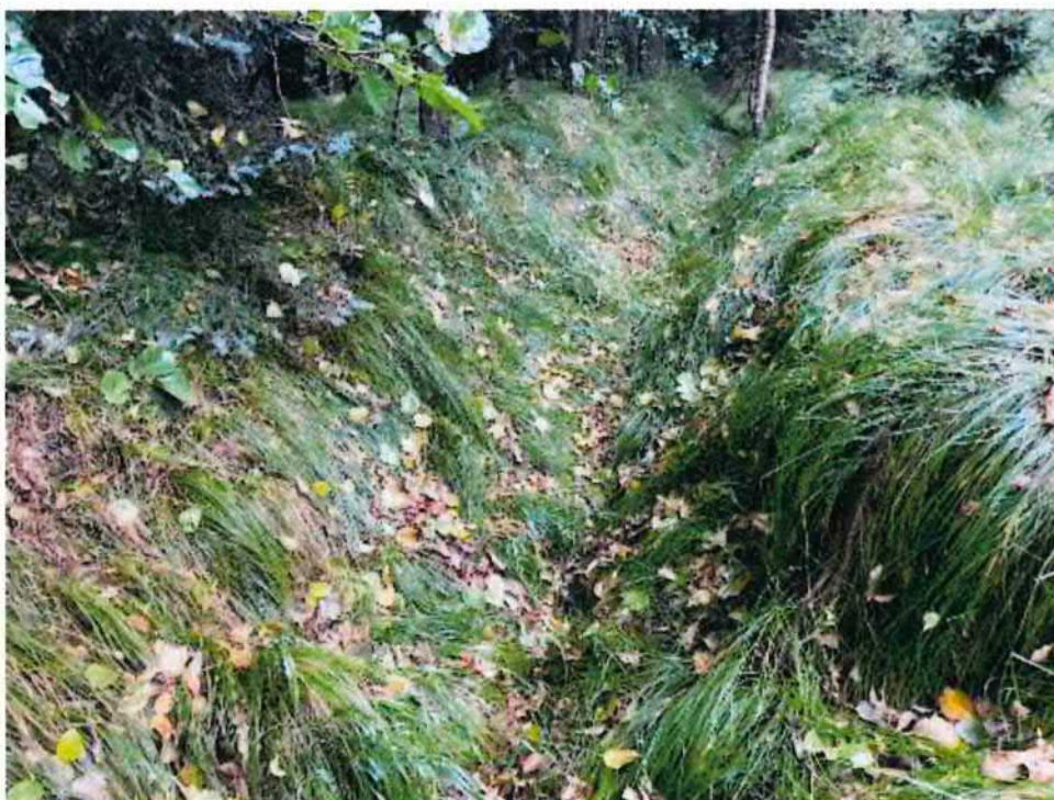
Obrázek 2: Původní stav melioračního příkopu
