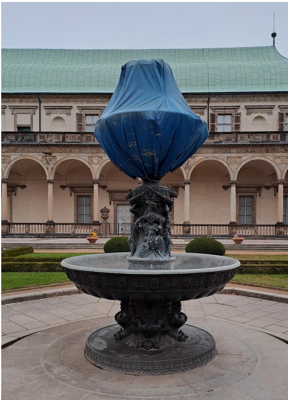
Fotografie aktuálního stavu kašny ke konci prosince roku 2024, čtrnáct měsíců po posledním restaurátorském zásahu. Po mechanickém odstranění vodního kamene byla původní patina ošetřena ochrannou vrstvou vosku. Na některých partiích povrchu je patrný opětovný vznik usazenin. Horní mísa s plastikou Dudáčka je každoročně zazimována pod ochrannou plachtou.
