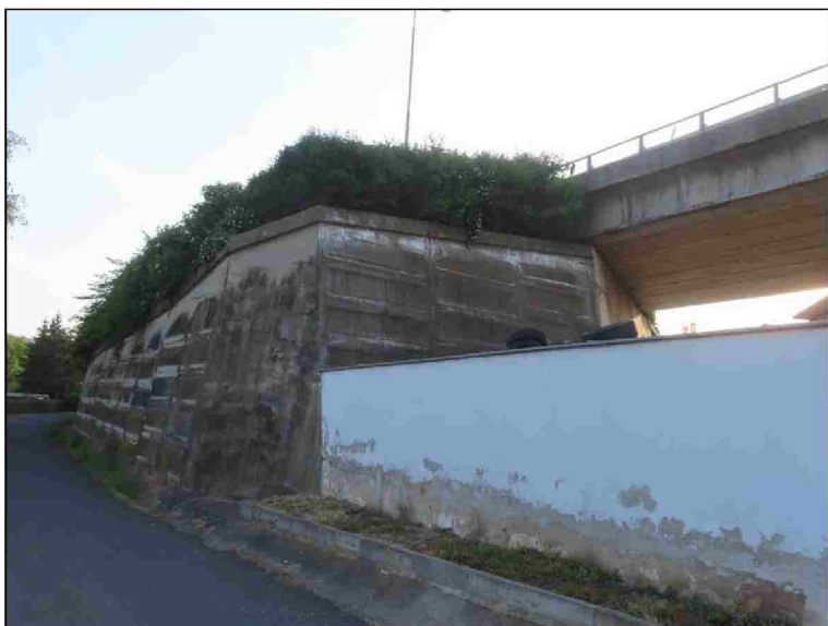
Pohled na OP1 zprava
