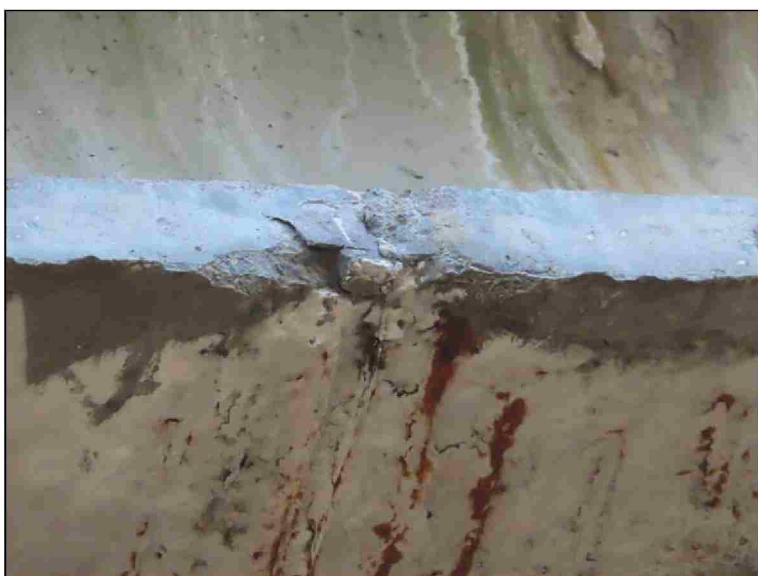
Pohled od Pi2 zprava do 2. pole 8. nosník- provedená sanace- opět separace krací vrstvy
