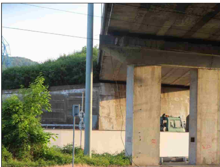
Pohled na Pi2 zprava a do 2. pole
