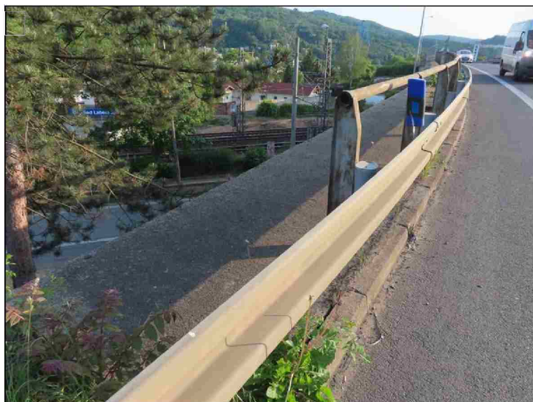
Levá strana za OP4 Deformace svodidla
