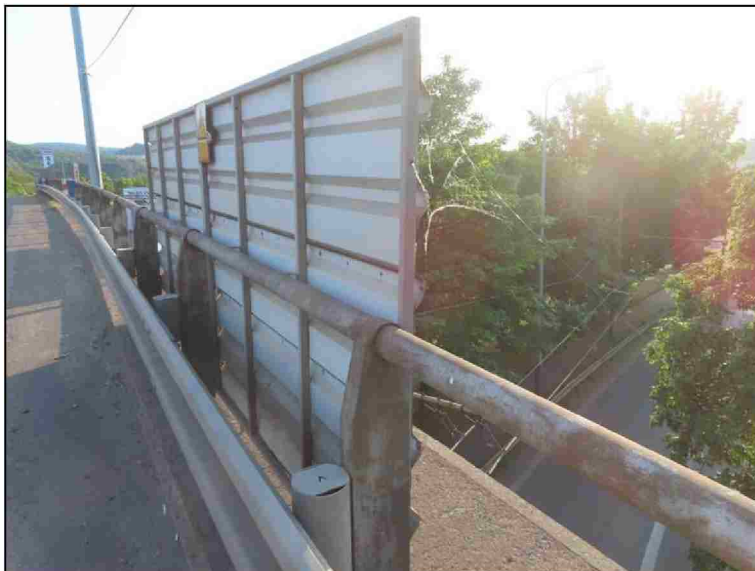
Levá strana 3. pole Protidyková zábrana
