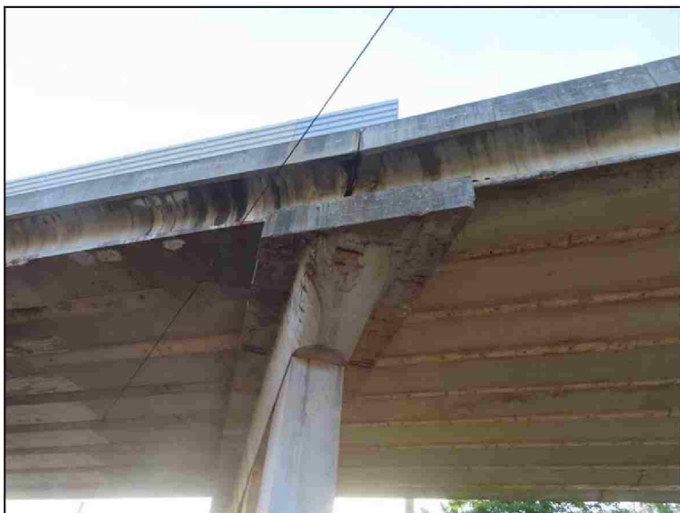
Pohled na Pi3 zprava ze 2. pole
