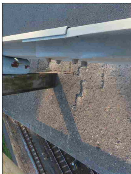
Pravá strana 2.pole Římsa-separace krycí vrstvy
