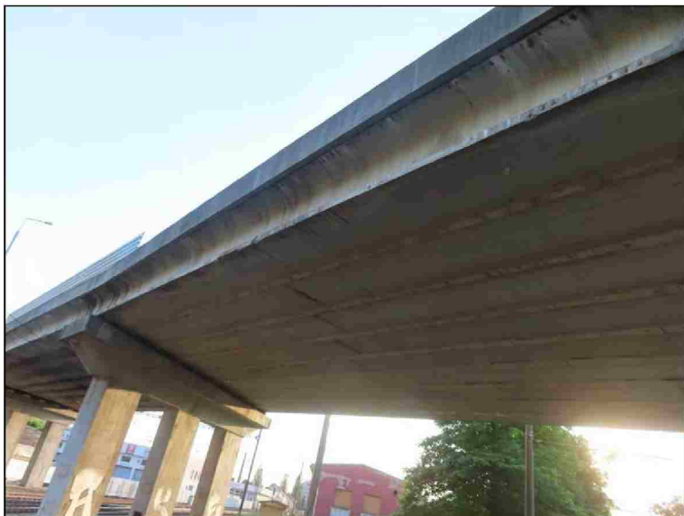
Pohled na Pi3 zprava a do 3. pole 8. nosník- obnažen kanálek předpínací výztuže
