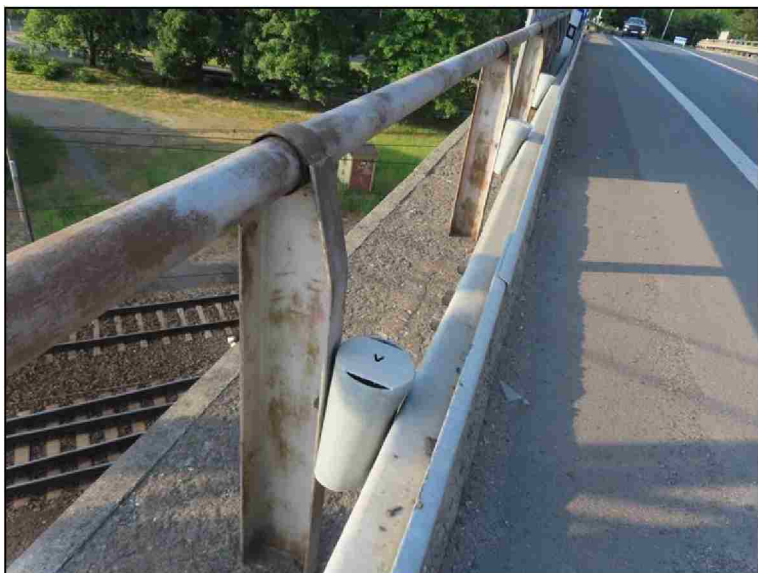
Levá strana 1. pole Zábradelní svodidlo-deformace
