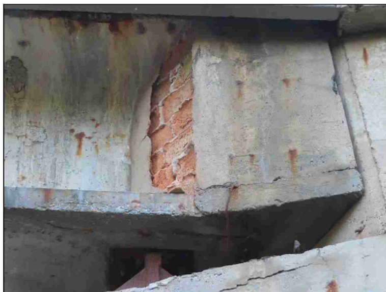
Pohled nad OP4 a křídlo zprava Vyzdívka - ztracené bednění dobetonávky kotev
