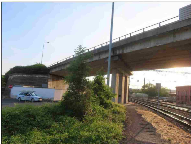
Pohled na Pi2 zprava ze 2. pole
