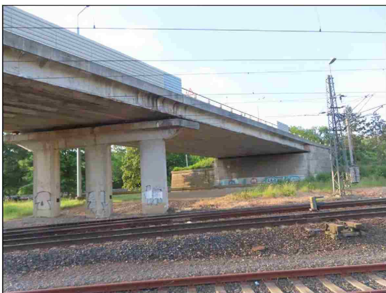
Pohled na Pi3 zprava ze 2. pole
