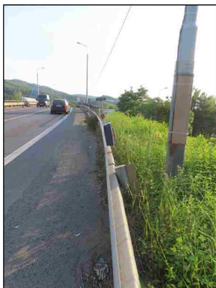
Levá strana za OP4 Deformace svodidla
