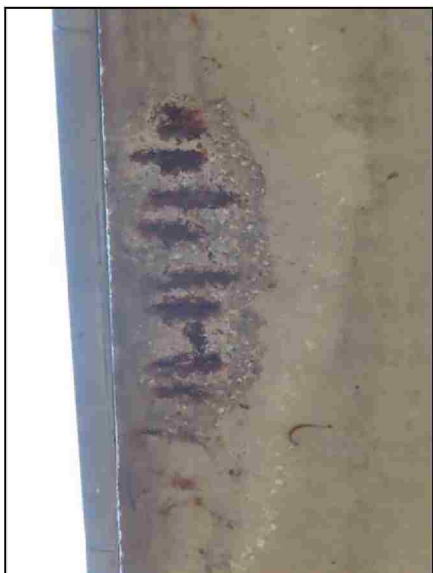
Pohled na Pi3 zprava a do 3. pole 8. nosník- obnažen kanálek předpínací výztuže
