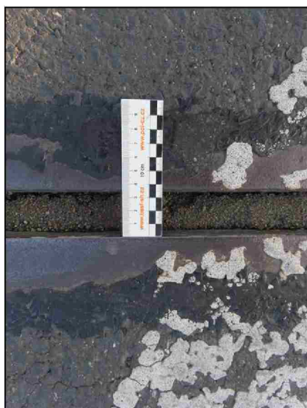
MZ Pi3 LS Měření š. dilatační spáry
