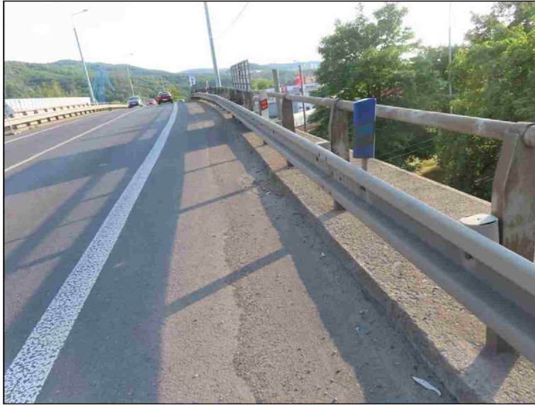
Levá strana 3. pole Zanesená krajnice
