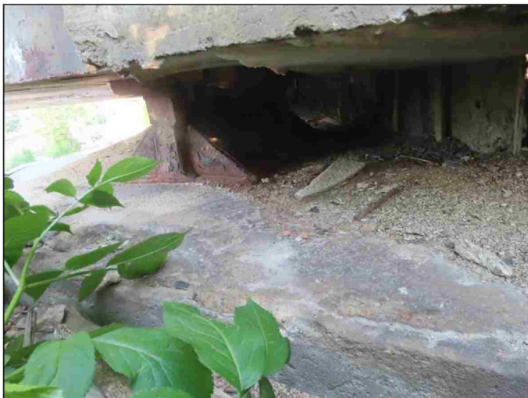
Pohled nad OP1 zleva Dozdívka konce krajního nosníku
