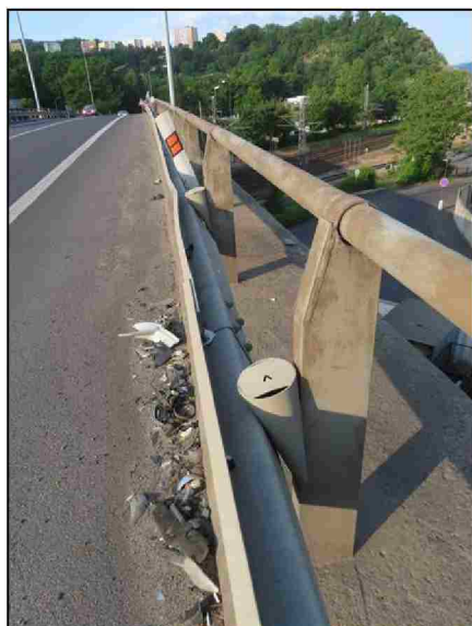
Pravá strana 1. pole Zábradelní svodidlo-- deformace od nárazu
