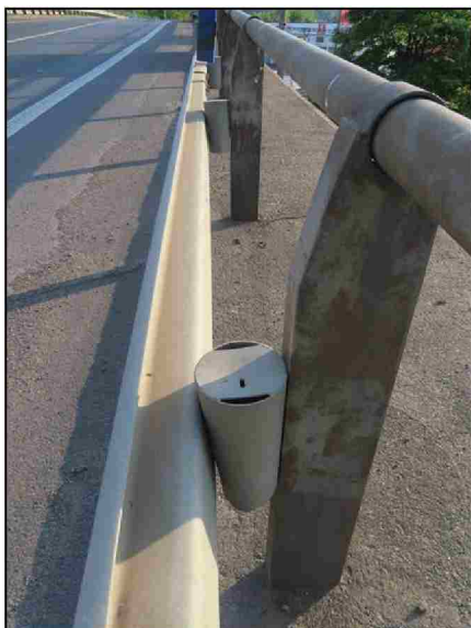
Levá strana za OP4 Deformace svodnice a def. dílu
