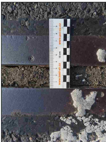
MZ Pi3 z PS Šířka dilatační mezery 35 mm
