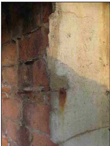
Pohled nad OP1 zleva Dozdívka konce krajního nosníku
