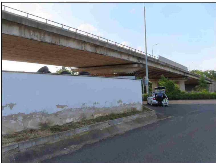
Pohled na most od OP1 zprava
