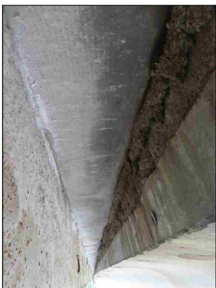
Pohled od OP1 zleva Vyrovnávací deska-nekvalitní beton- možnost separace úlomků
