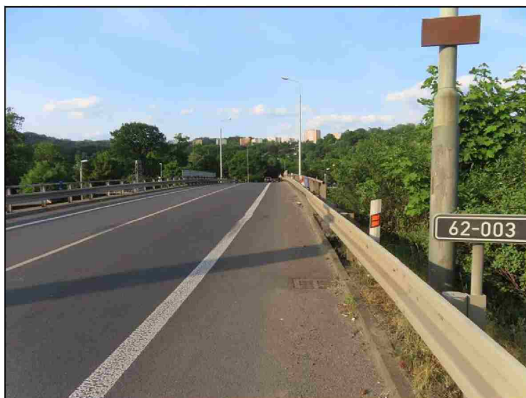
Pravá strana 1. pole Zábradelní svodidlo-- deformace od nárazu
