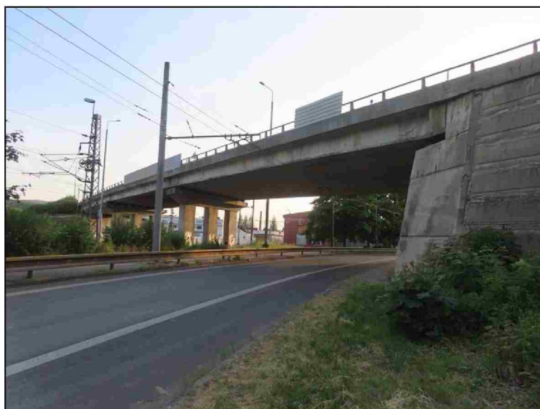
Pohled na most od OP4 zprava
