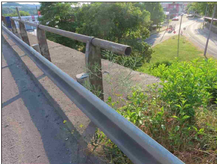
Levá strana za OP4 Deformace svodnice a def. dílu
