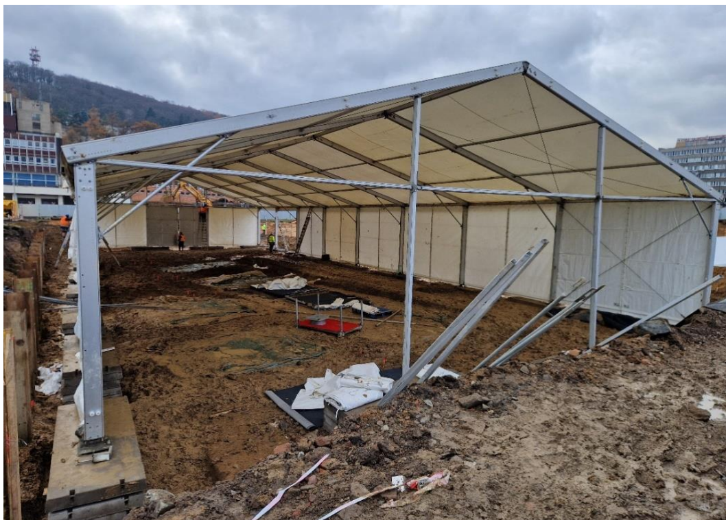
Příloha B – Fotodokumentace – montáž stanu pro archeologické pracovníky, který zakrývá plochu nálezů – Technické zabezpečení stavby včetně vyhřívání, součinnosti „D“ pracovníků, THP stavby, bagru a TIR
