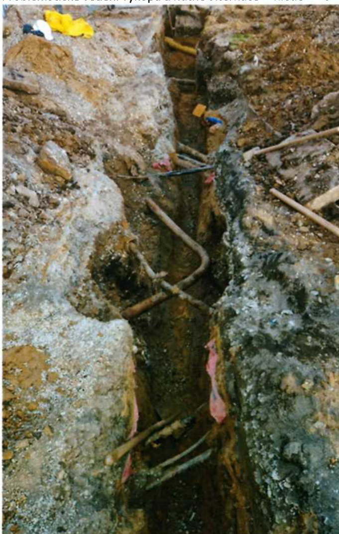
b) Problematické vedení výkopu a nutné alternace vzhledem ke kolizím a normovým odstupům
