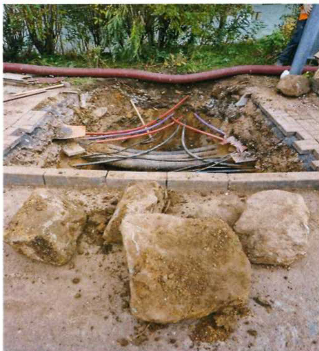
b) Problematické vedení výkopu a nutné alternace vzhledem ke kolizím a normovým odstupům
