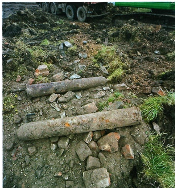
K Bodu č.3 - Bourací práce a vyklízení v minulosti nezlikvidovaných základových konstrukcí v kombinaci – beton, cihla a kameny FOTO A. Včetně odstranění starých zanechaných předmětů včetně tlakových kyslíkových lahví FOTO B
