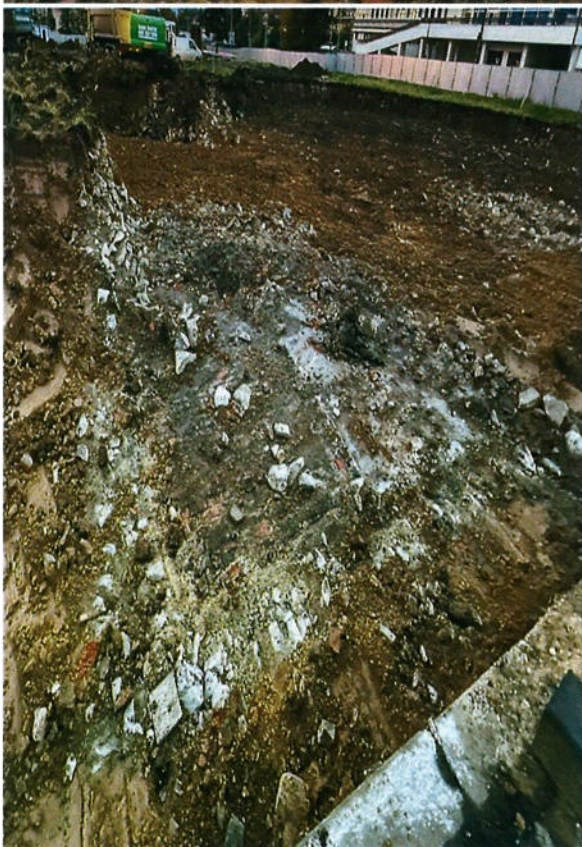
K Bodu č.3 - Bourací práce a vyklízení v minulosti nezlikvidovaných základových konstrukcí v kombinaci – beton, cihla a kameny FOTO A. Včetně odstranění starých zanechaných předmětů včetně tlakových kyslíkových lahví FOTO B
