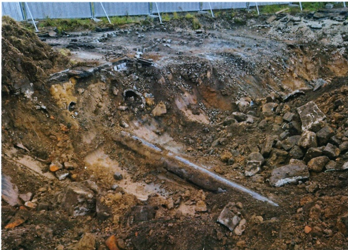
K Bodu č.3 - Bourací práce a vyklízení v minulosti nezlikvidovaných základových konstrukcí v kombinaci – beton, cihla a kameny FOTO A. Včetně odstranění starých zanechaných předmětů včetně tlakových kyslíkových lahví FOTO B
