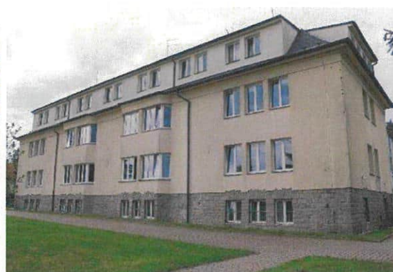
Obrázek 3 - Pohled II – hlavní budova
