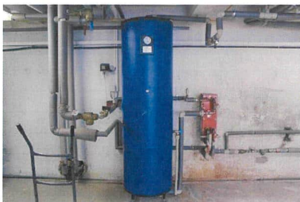
Obrázek 13 - Příprava TV v budově A
