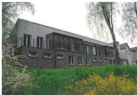
Obrázek 5 – Pohled II – Technický monoblok
