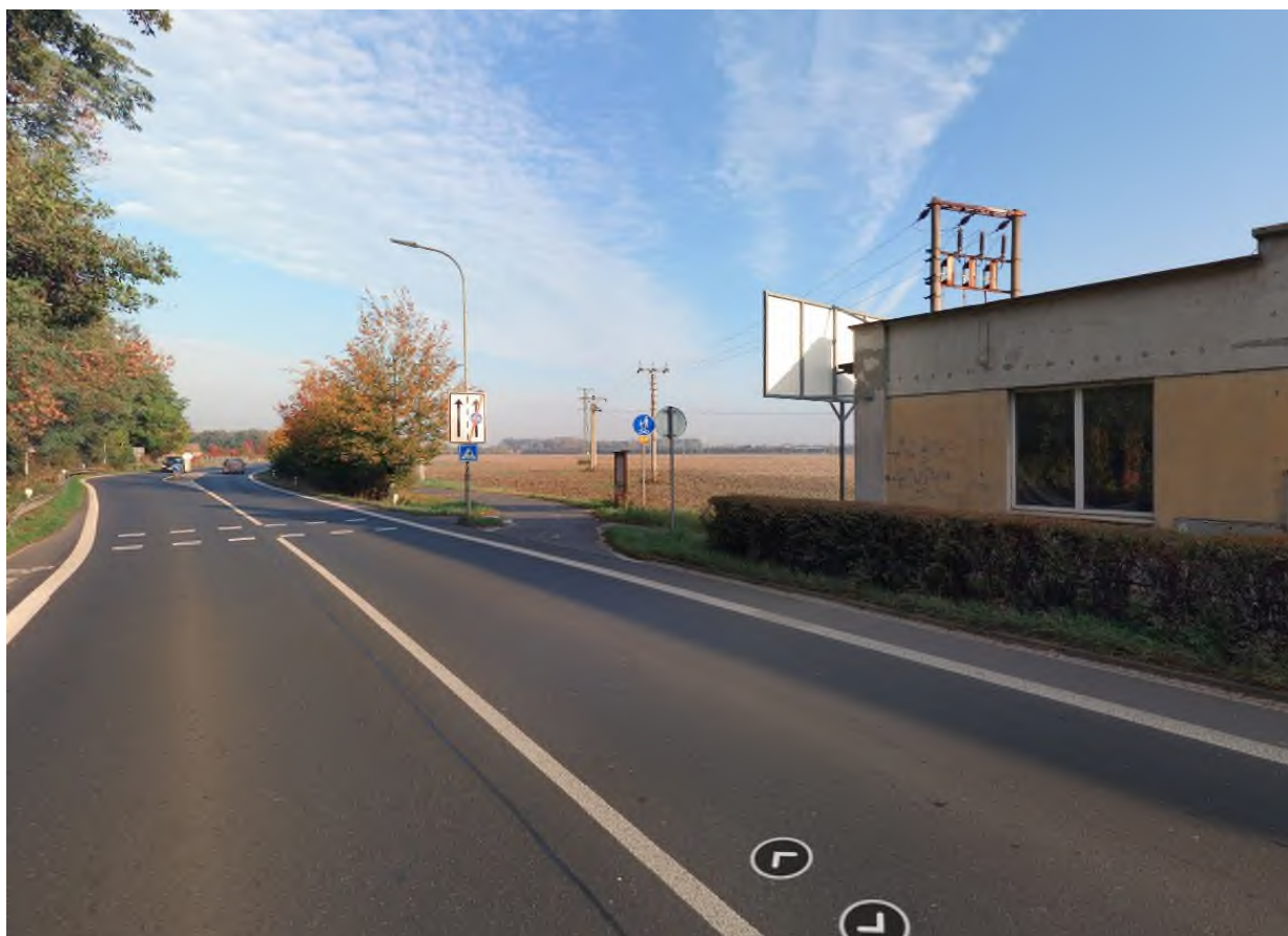
Nevyužívaný chodník na východní straně komunikace
