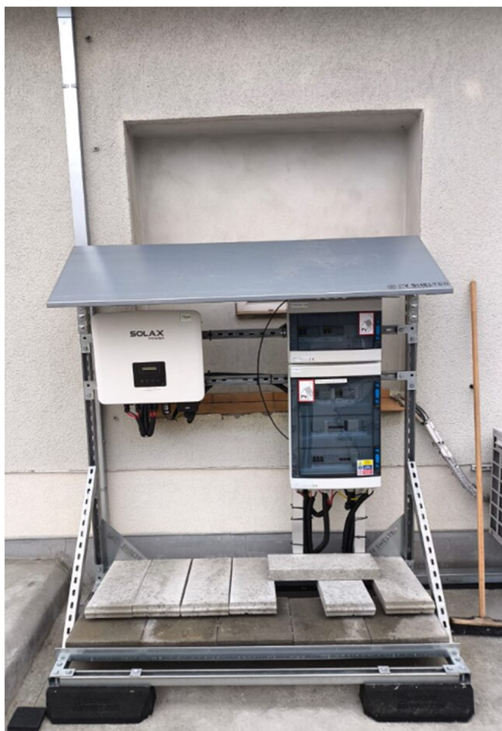
Obrázek 8 Orientační zobrazení uchycení střídače a fve rozvaděče
