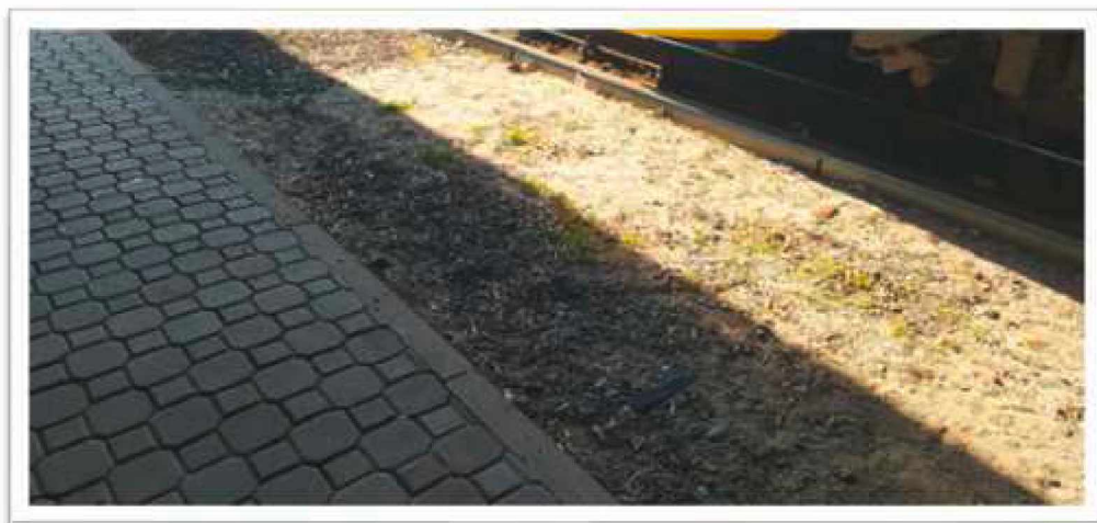
Foto č.1: ŽST Otrokovice – Nedopalky na nástupišti.
