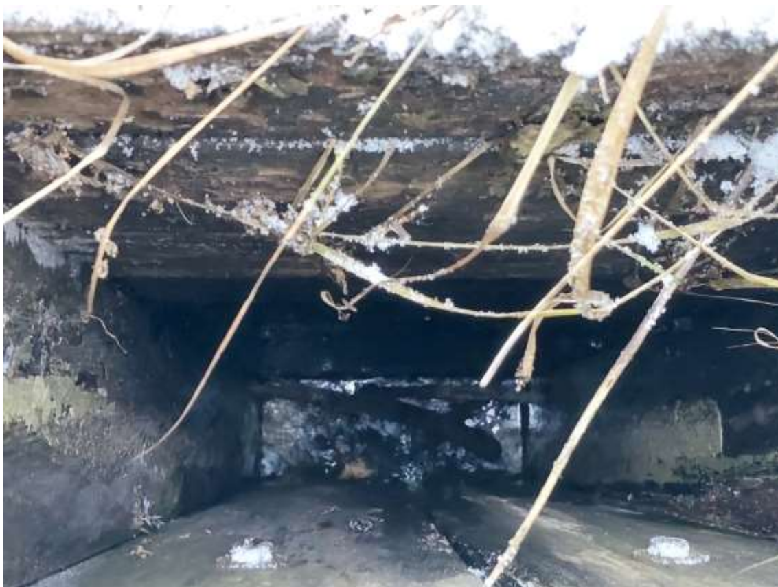
Pohled do požeráku, voda protéká mezi zadními prkny
