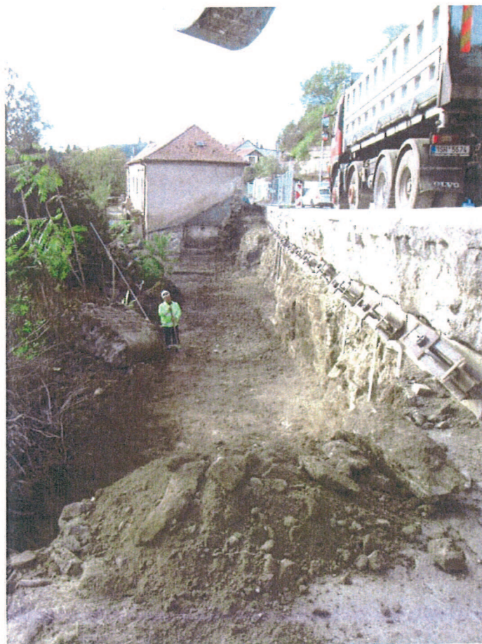
SO 251.4 - 4.úsek zdi - spára pro 2.kotevní úroveň
