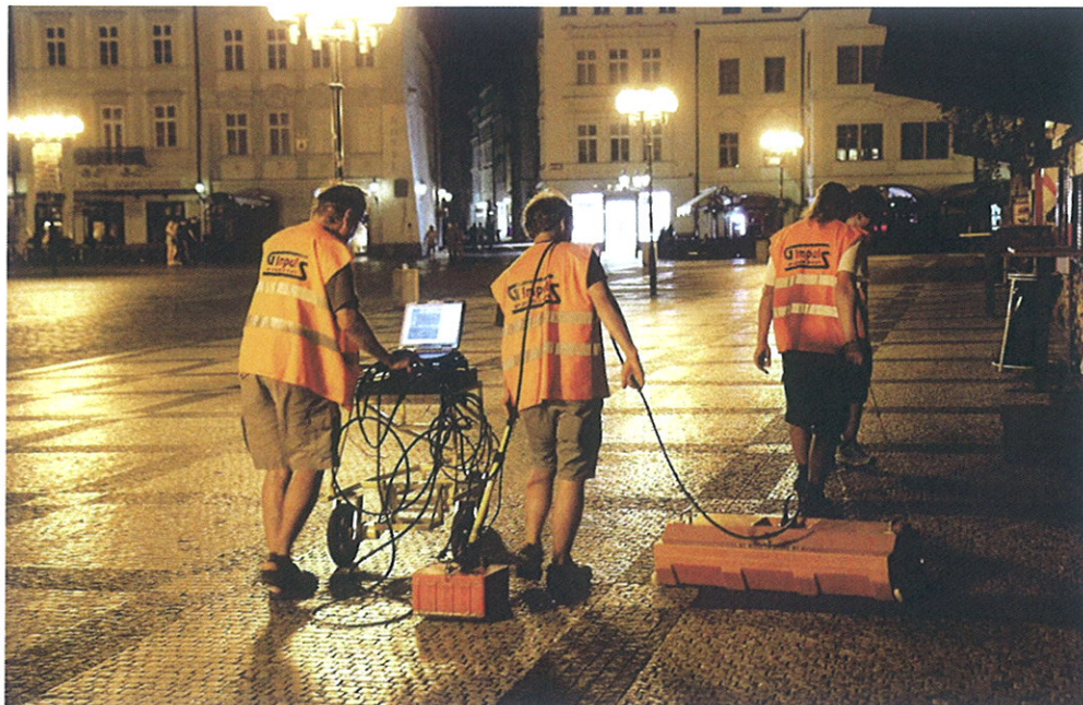
Obr. 2: Měření s radarem SIR 20 (ilustrační foto ze Staroměstského náměstí)
