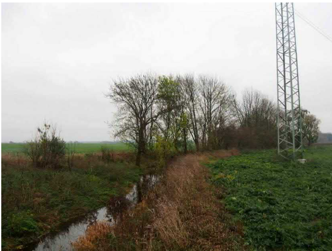
Obr. č. 9: Pohled na ochranné pásmo VVN ČEPS 400kV
