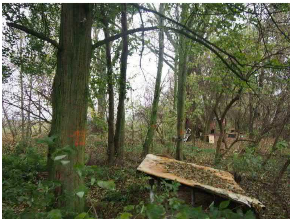
Obr. č. 12. Pohled na myslivecké stavby uprostřed doprovodného porostu VT Šumice
