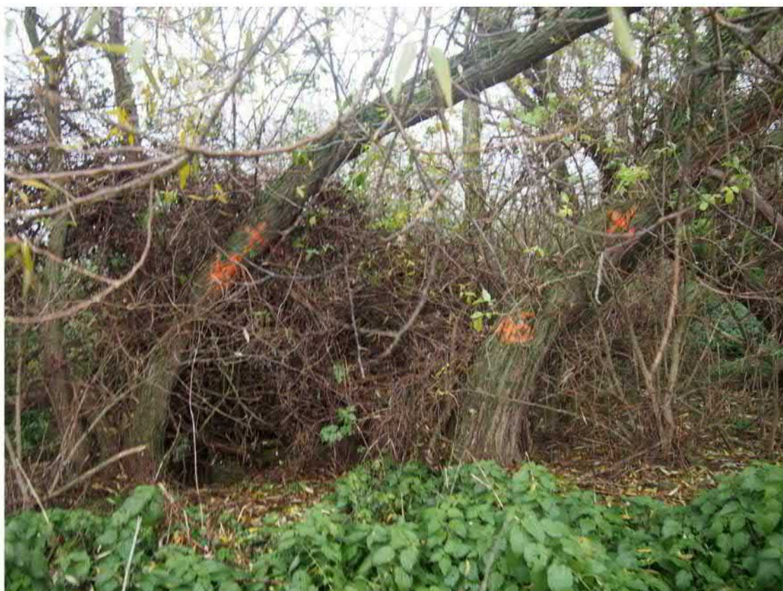
Obr. č. 8: Silně nakloněné vrby hrozící zlomením, navrženo vykácení
