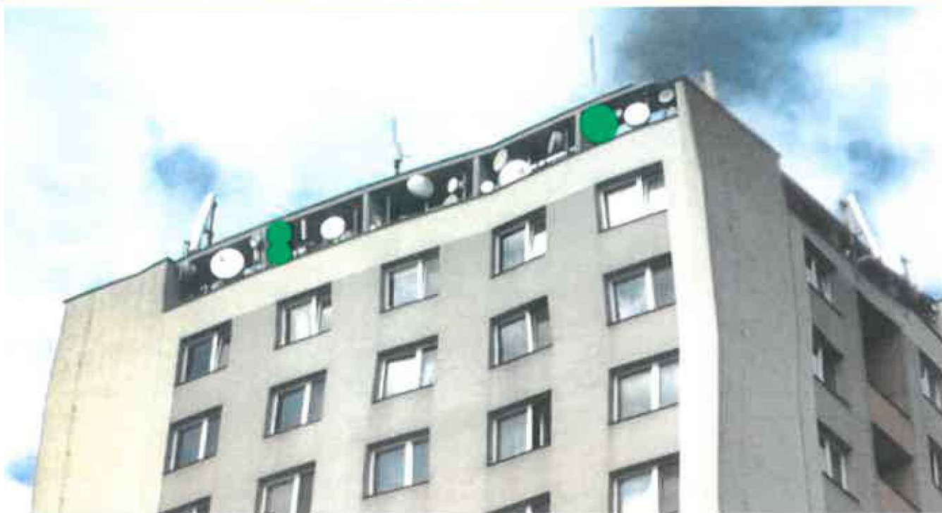
Pohled z východu
