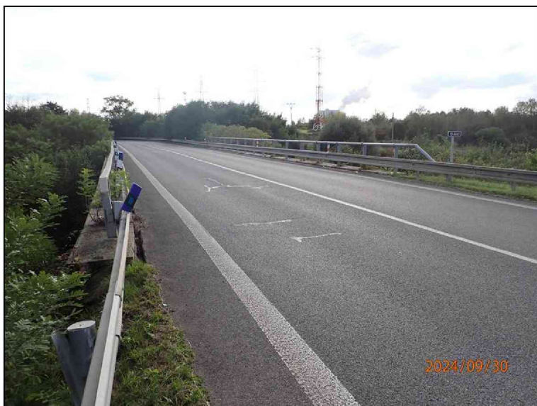
02_Pohled proti směru staničení.JPG
