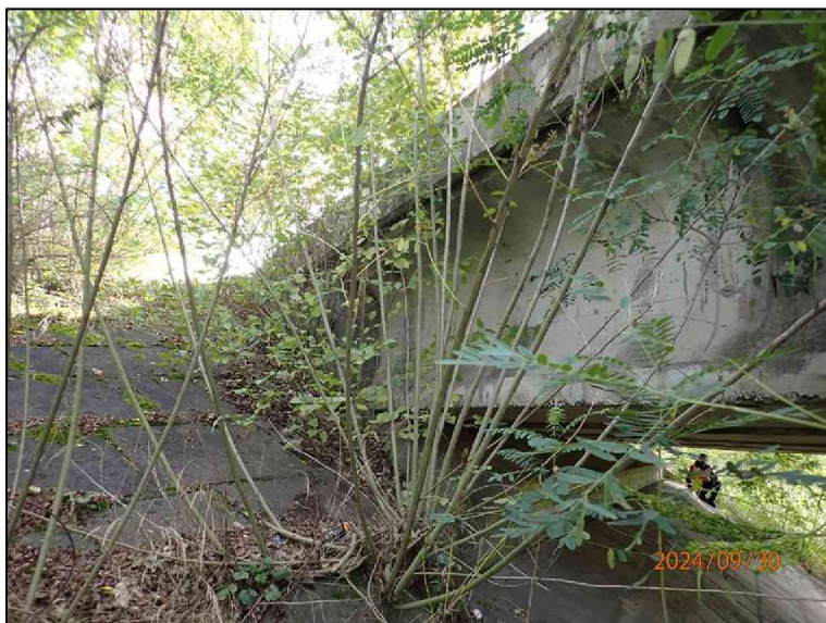
08_Pravé křídlo O1.JPG
