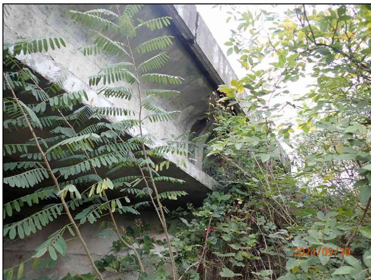
11_Pravé křídlo O2.JPG
