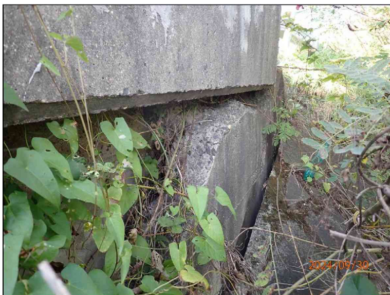
12_Pravé křídlo O2.JPG
