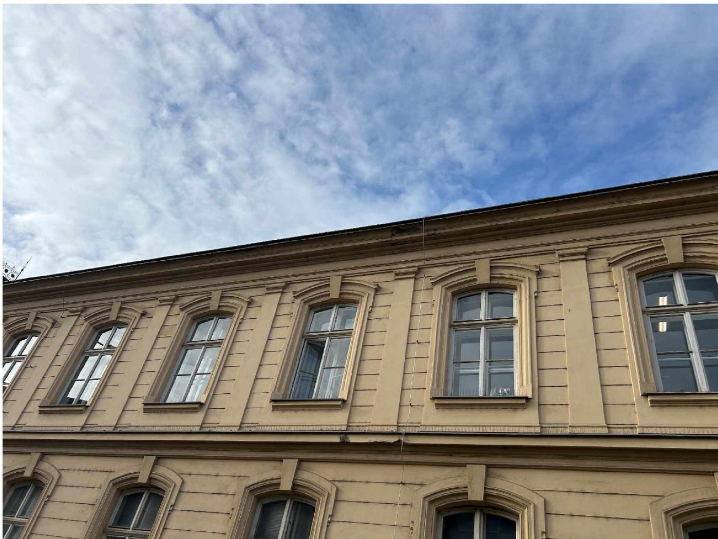
2x římsa, pod střechou a pod oknem
