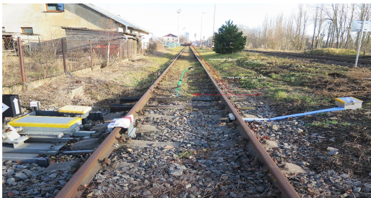
2. fotodokumentace zachycující předmět daru v terénu - nový styk drah v km 17,029 + zájmový úsek koleje
