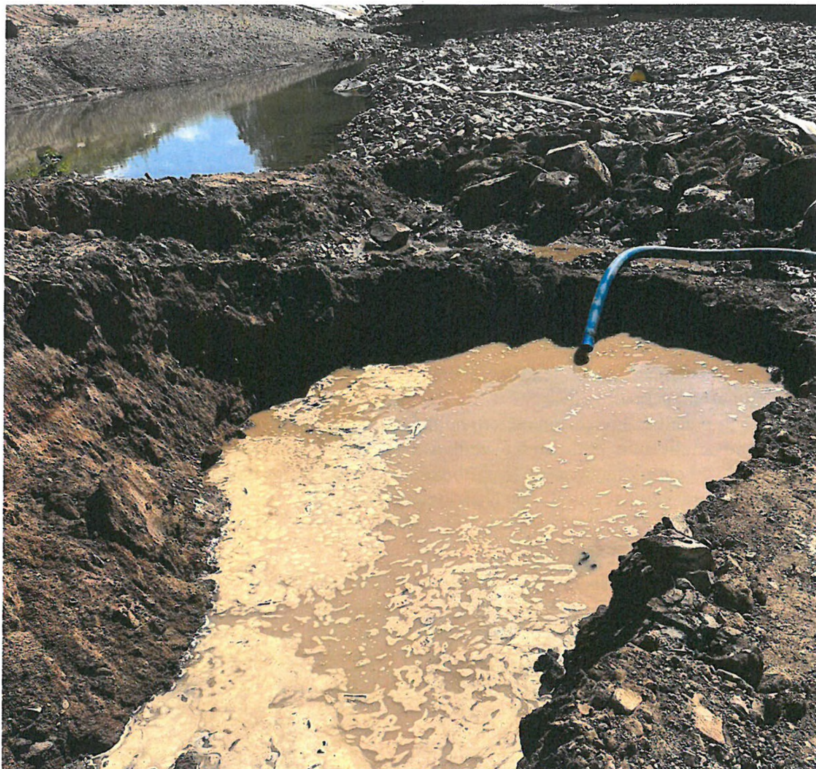
Obr. č. 6: Stavební jáma v místě založení SO 07.08, 30. 7. 2024
