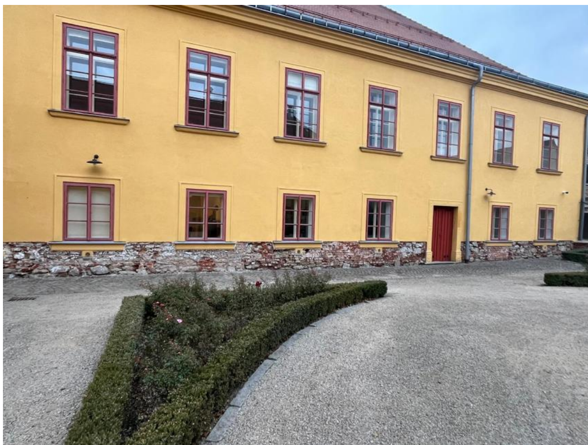
b) sokl a plot čestného dvora Lannerova domu
