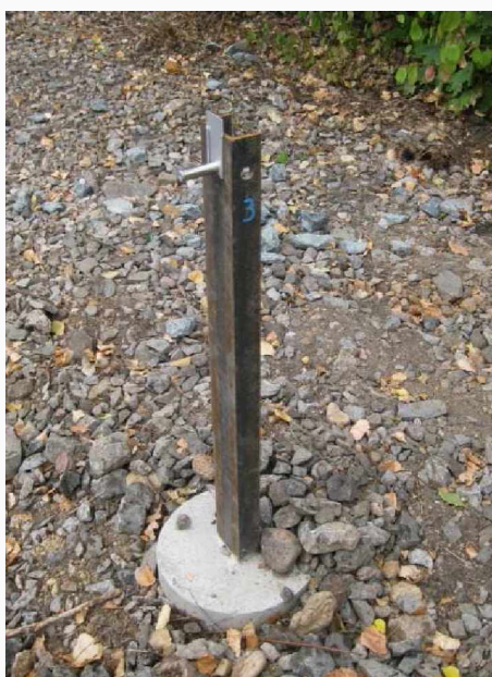
Obrázek 20 Otevřený profil konstrukce sloupku ŽPSV
