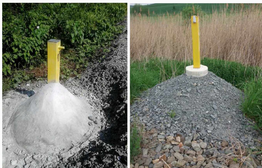
Obrázek 17 Řešení zhotovitele pro zvýšení stability zajišťovací značky
