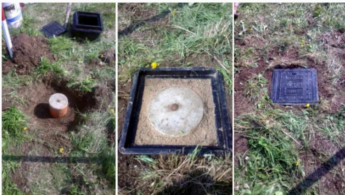
Obrázek 41 Příklad řešení plastové šachty hranaté
