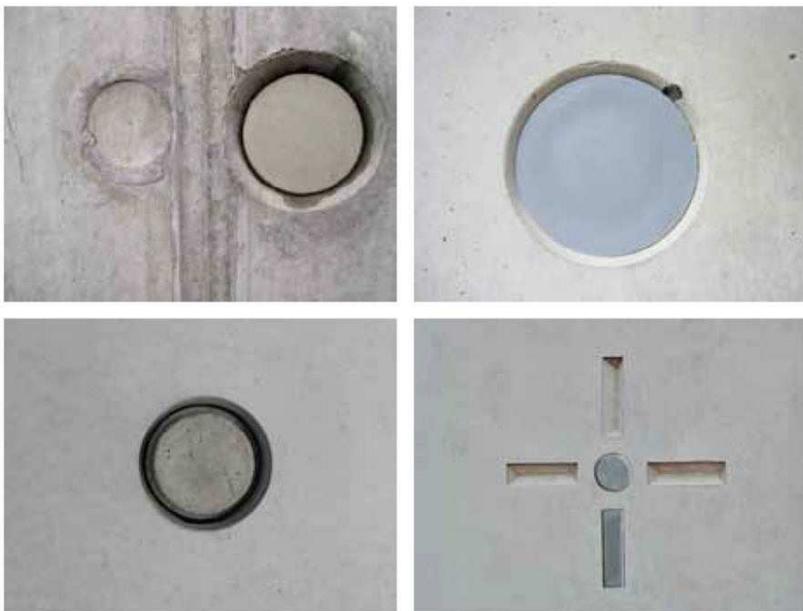
(23) Obr. F.2 – Různé způsoby uzavření spínacích otvorů
