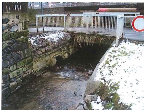
ř.km 0,020 – mostek komunikace u soutoku
