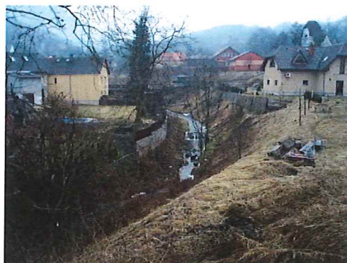
ř.km 0,225 – nad železnicí
