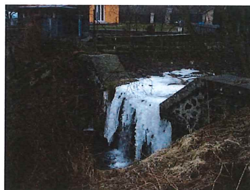
ř.km 0,505 – těleso závěrné retenční přehrážky
