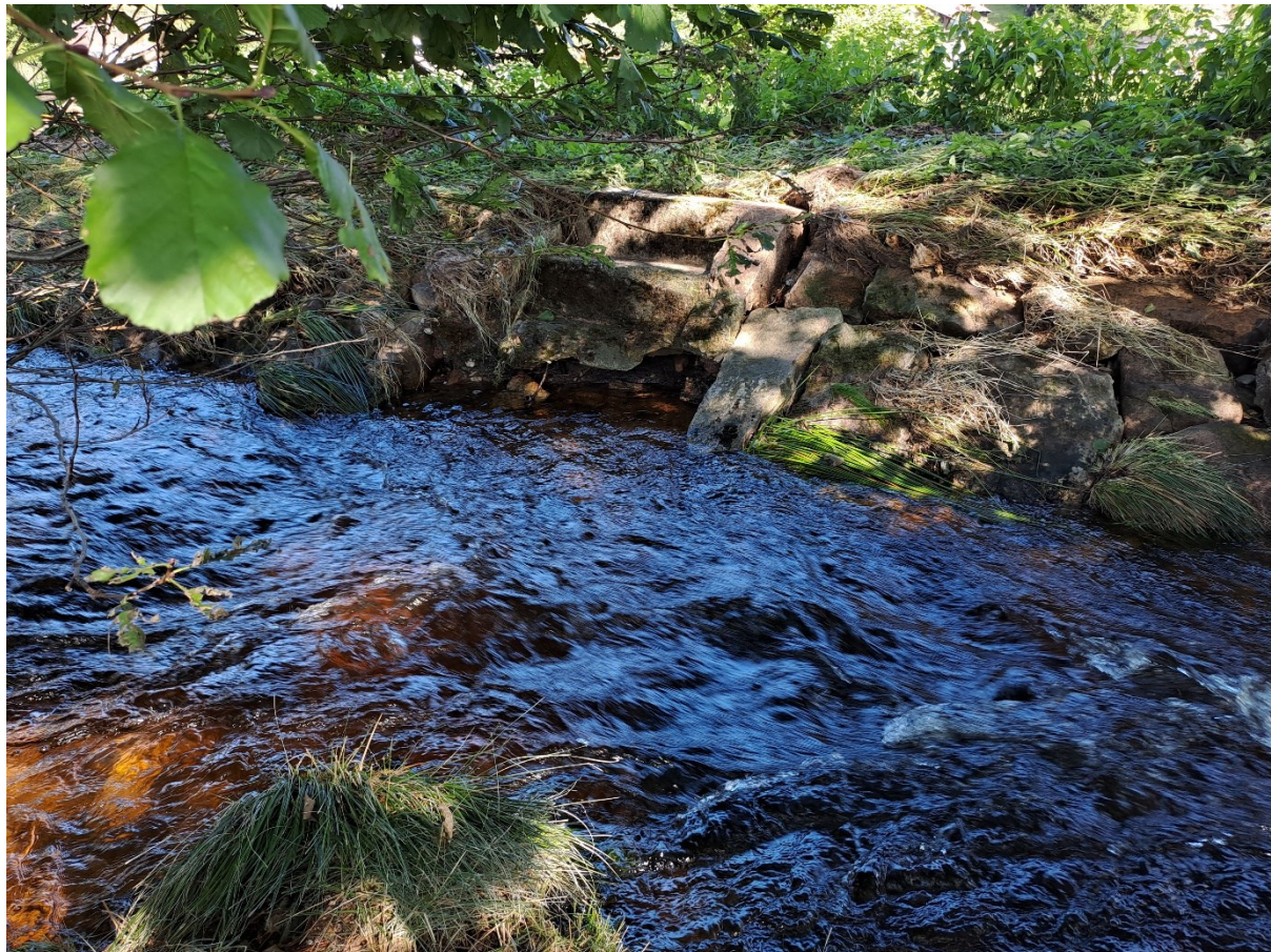
Foto č.4 – drobná kaverna v opevnění
