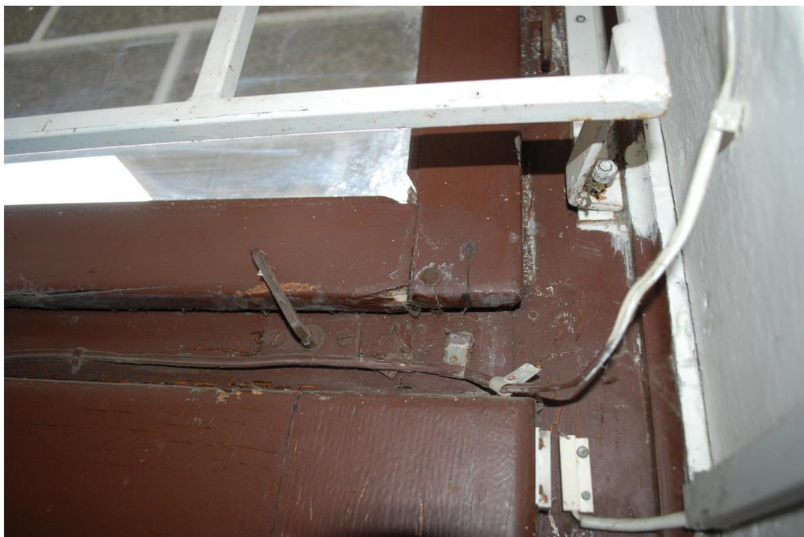
Otvírka světlíku - dodatečně přidáný obrtlík.
