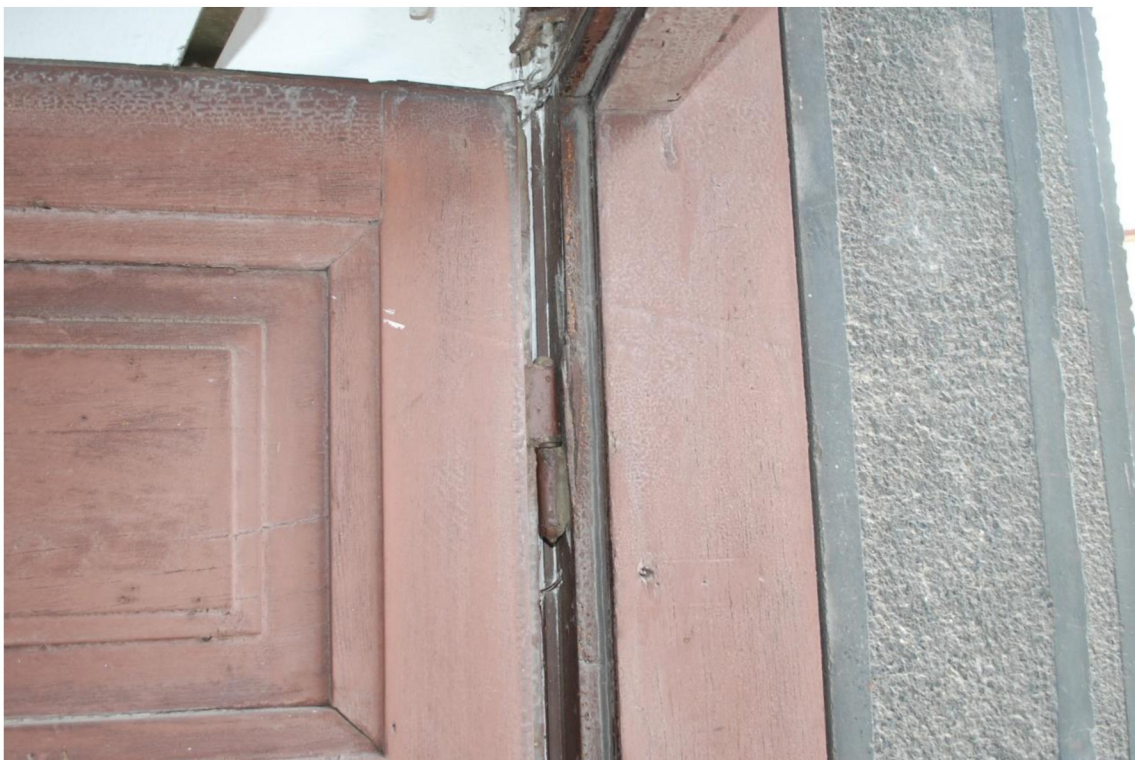
Horní pant dveřního křídla.
