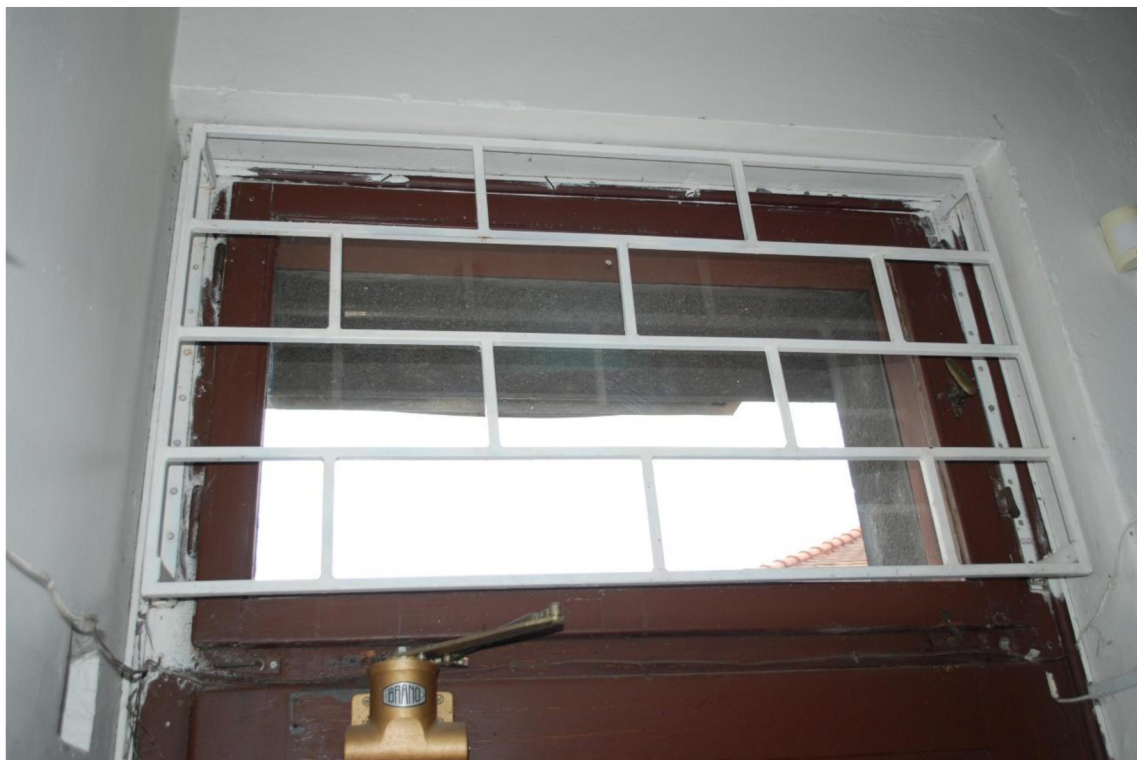
Otvírka světlíku – vnitřní strana.
