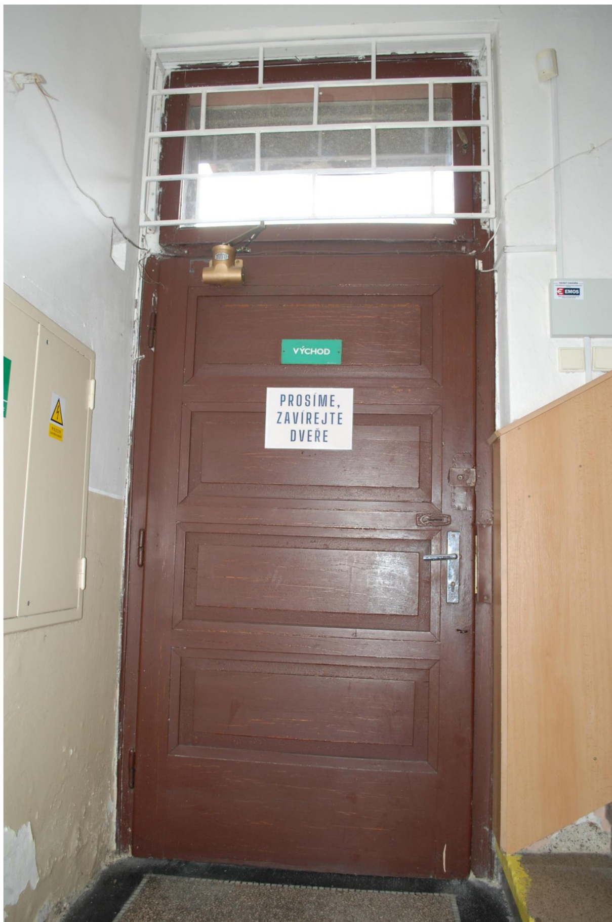
Dveře se světlíkem – vnitřní strana.
