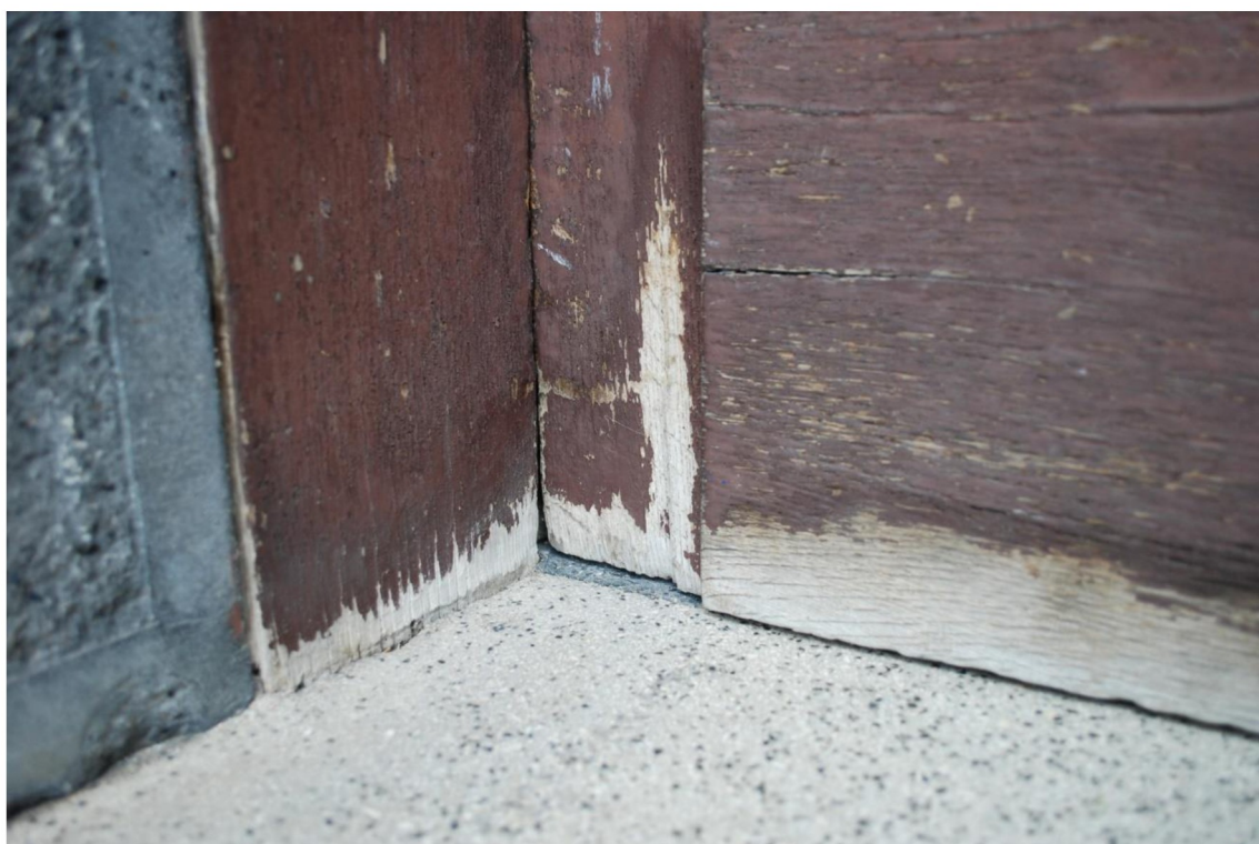
Spodní část dvevního křídla a zárubně.
