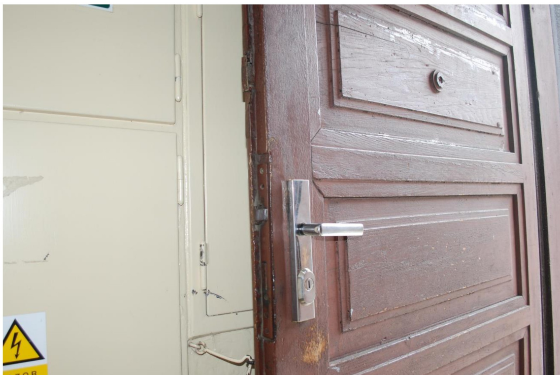
Nepůvodní zámek, klika a štítek - vnější strana.
