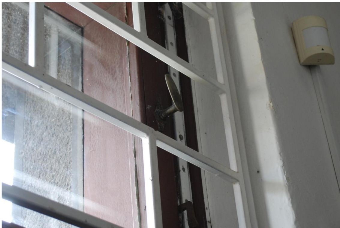
Otvírka světlíku – původní půloliva.
