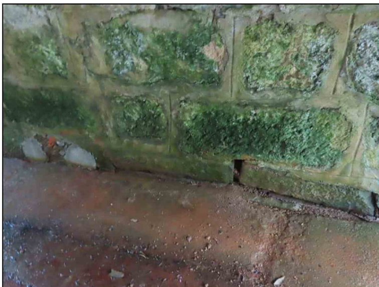
Pohled směrem k OP1 zleva Původní část - u paty vyplavené výplně spár
