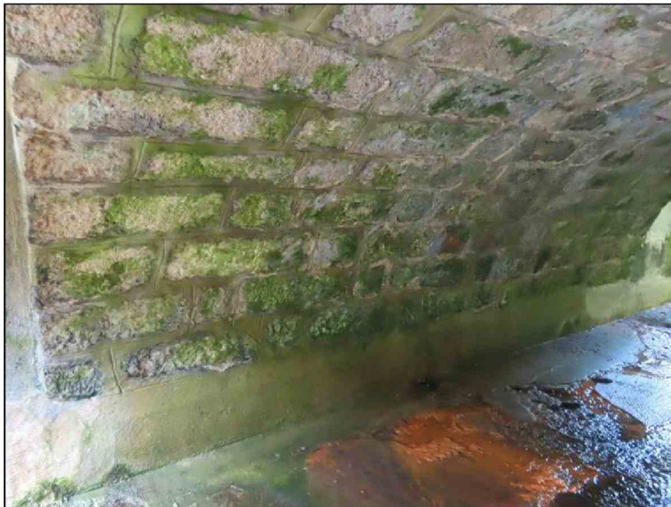
Pohled směrem k OP2 zleva Původní část a pravé rozšíření - u paty průsaky
