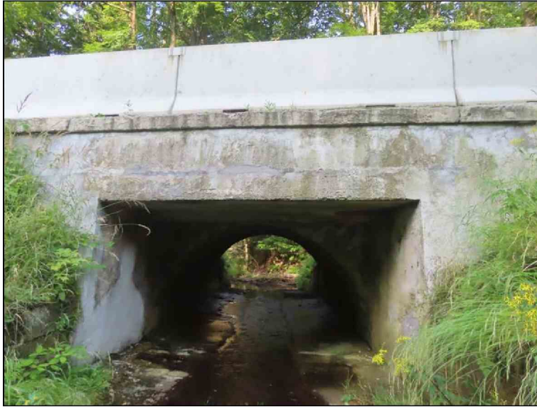
Pohled na OP1 a křídlo zleva Stopy po průřezcích pod římsou
