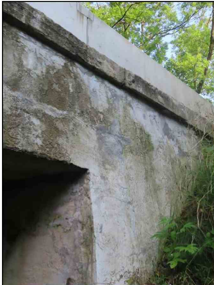
Pohled na OP1 a křídlo zleva Stopy po průřezcích pod římsou
