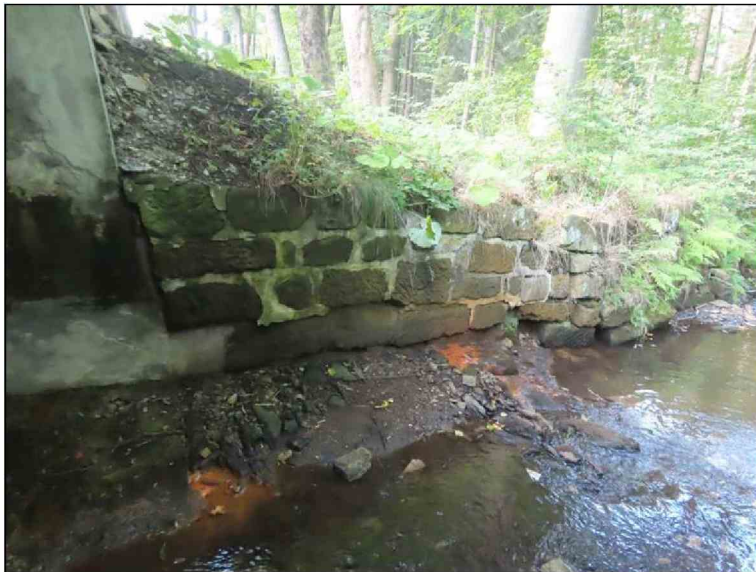
Pohled na OP1 a křídlo zprava Rozpad zdiva
