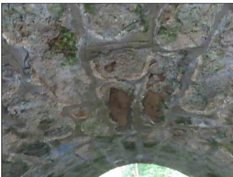
Pohled zleva Původní část- vrchol klenby- zvětrávání kamene
