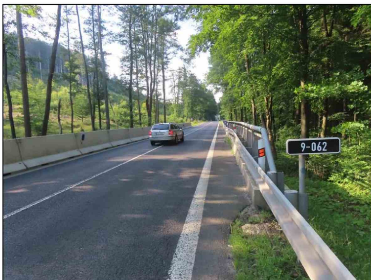
Pohled na uspořádání na mostě po směrustaničení
