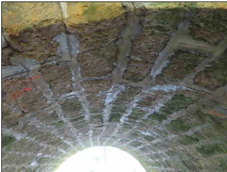
Pohled zleva Původní část- vrchol klenby- zavlhlý Původní část- vrchol klenby- zvětrávání kamene
