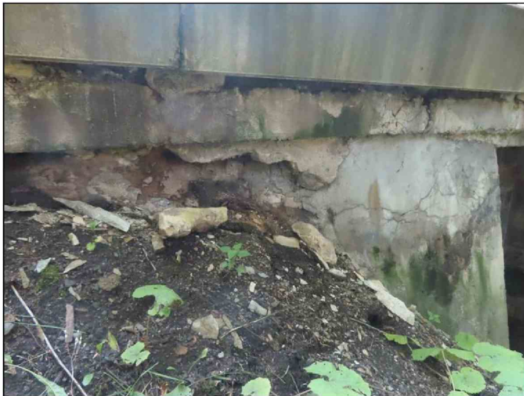
Pohled na OP1 a křídlo zprava Rozpad zdiva a betonu
