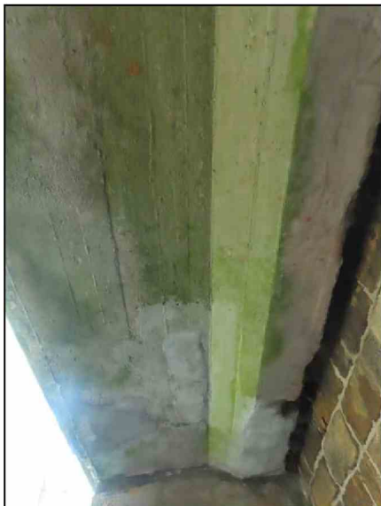
Pohled nad OP1 zprava Přechod mezi původní částí a pravým rozšířením- vyplněn zbytky stavebního materiálu
