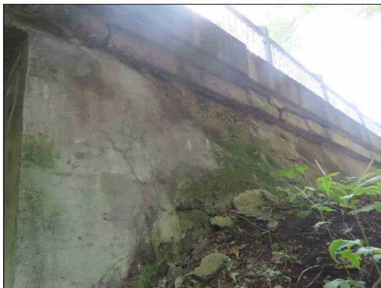
Pohled na OP2 a křídlo zprava Hloubková degradace původní římsy
