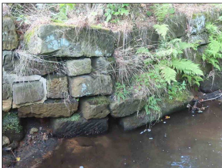
Pohled před OP2 zprava Regulační zeď -vysunutí a rozvolnění
