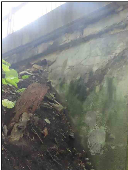
Pohled na OP1 a křídlo zprava Rozpad zdiva
