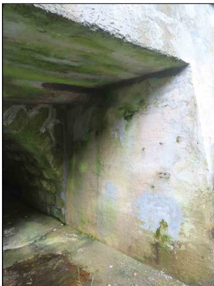
Pohled na OP1 zleva Stopy po průřezcích
