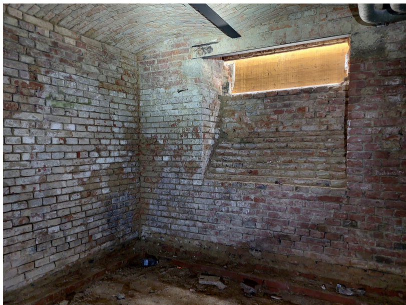
Obvodové zdivo – uliční stěna Kounicova – štítová stěna k objektu Kounicova 40
