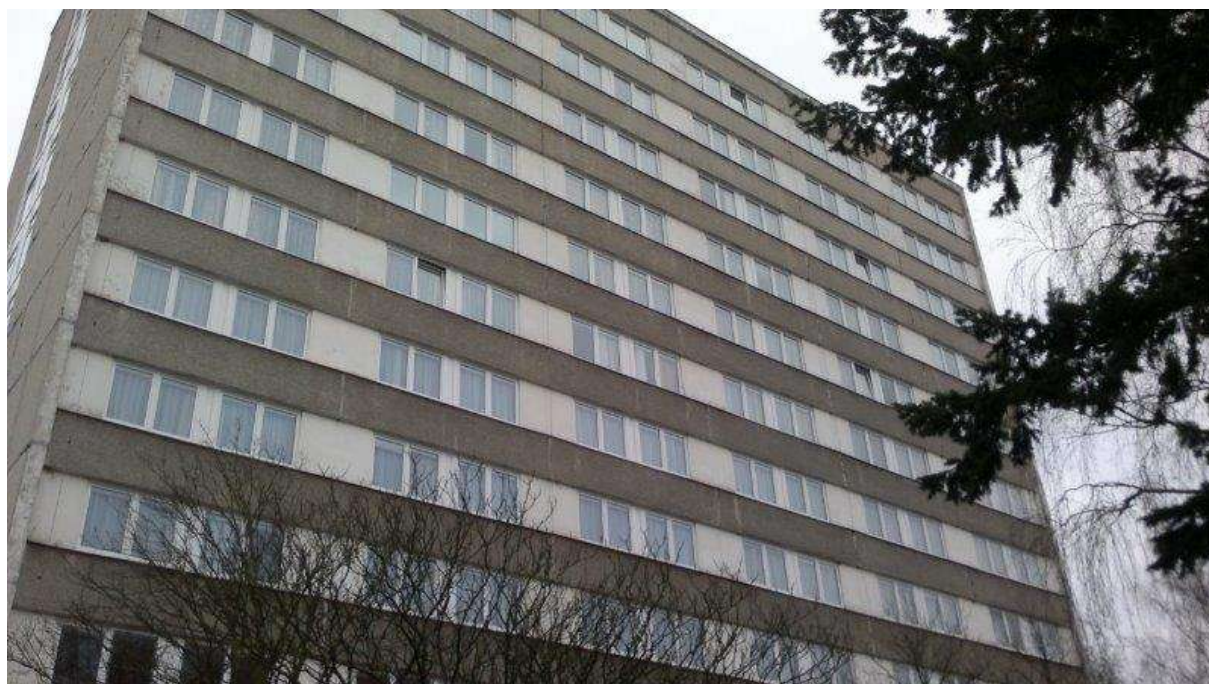
Objekt zaměstnanecké ubytovny Energetiků 321, Stráž pod Ralskem – východní pohled
