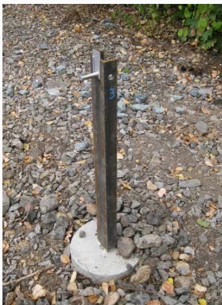
Obrázek 20 Otevřený profil konstrukce sloupku ŽPSV
