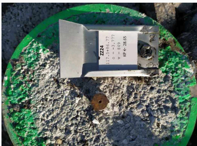
Obrázek 33 Roxor v betonovém bloku (základní odlehčená stabilizace)
