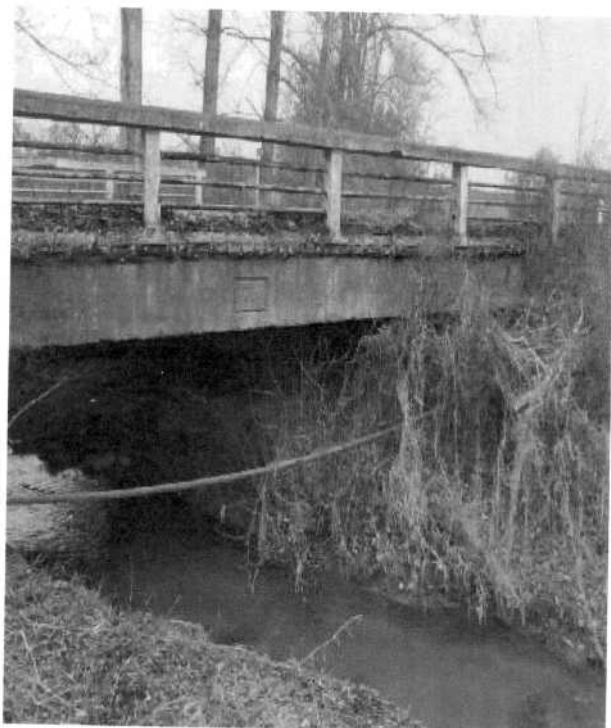
most ev. č. 228-011
