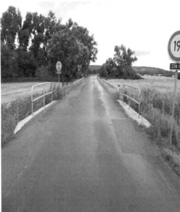
most ev. č. 228-010
