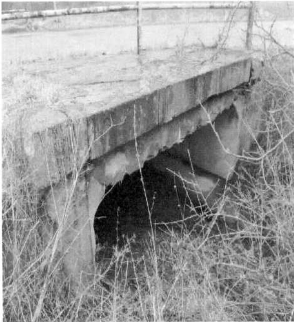
most ev. č. 228-007
