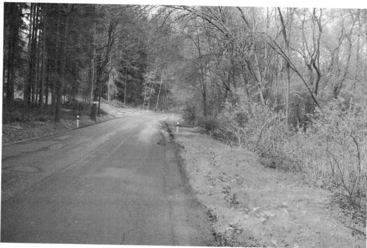
Povrch silnice a propustky
