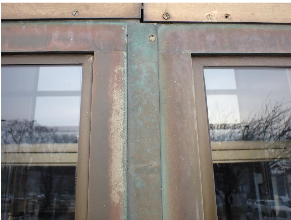
Levý roh -, poškozená MS klapačka křídla Střed dveří – mosazná klapačka, zoxidovaný povrch
