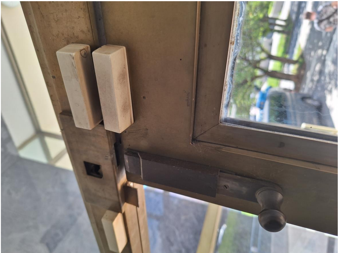
Dochovaná zástrč na vnitřních dveřích, tento typ navrhuji použít na vnějších křídlech Rozdílná barevnost – oxidace obkladu původního (světlejší) a novějšího (tmavší)
