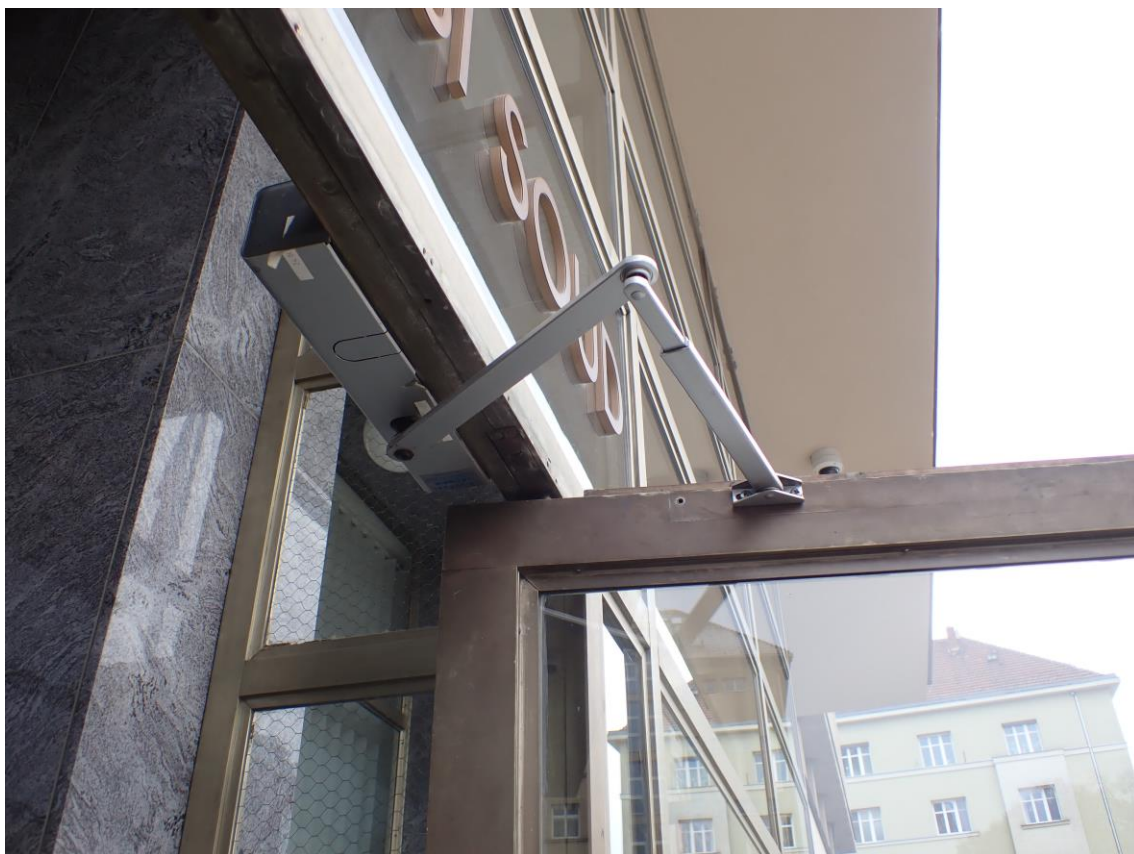
Nově osazený horní zavírač Assa Abloy bez pohonu, zatím funkční Poškozené zástrče v jaklovém rámu dveří
