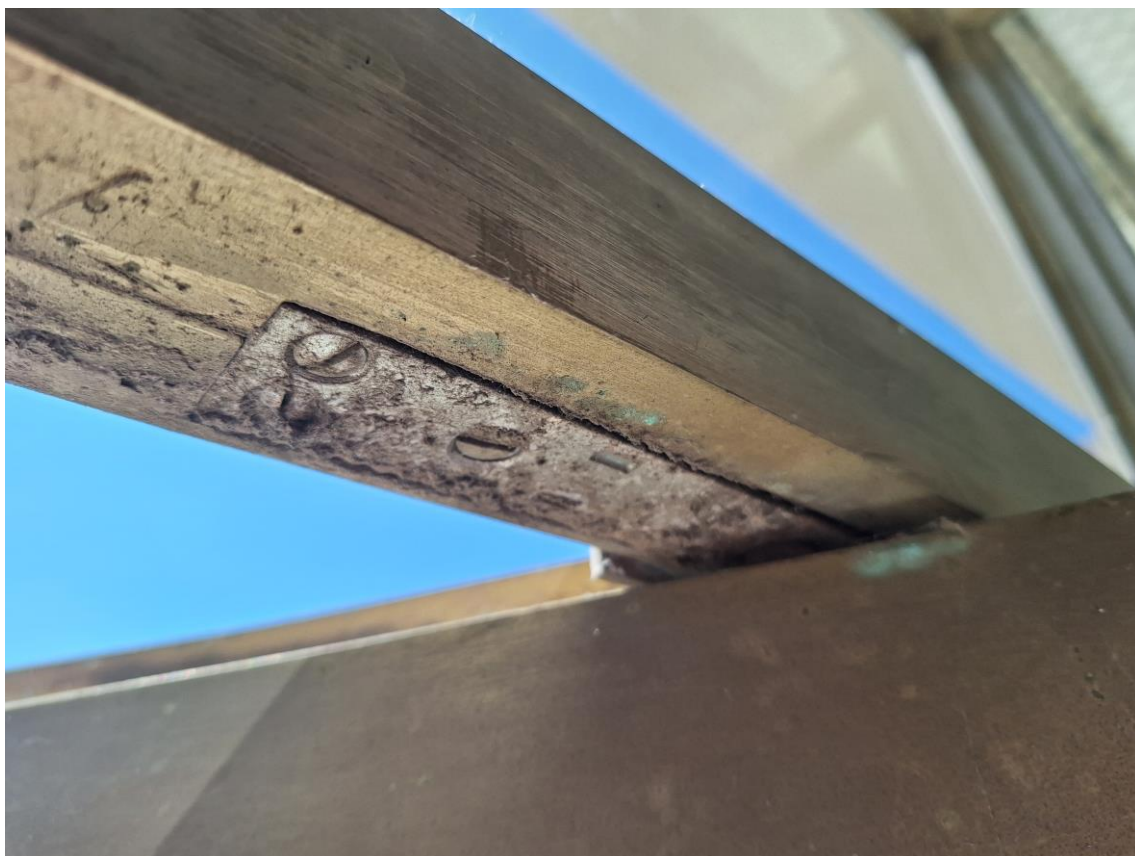
Horní protikus čepu umístěn v nadpraží Pohled na nefunkční zemní zavírač Geze Ts 550 N
