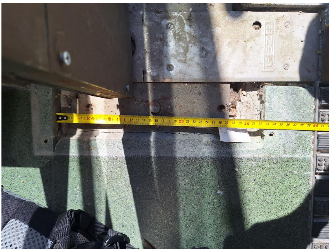
Horní protikus čepu umístěn v nadpraží Pohled na nefunkční zemní zavírač Geze Ts 550 N
