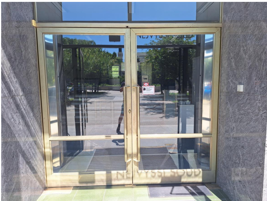
Pohled na původní dochované vnitřní dveře a způsob zasklení
