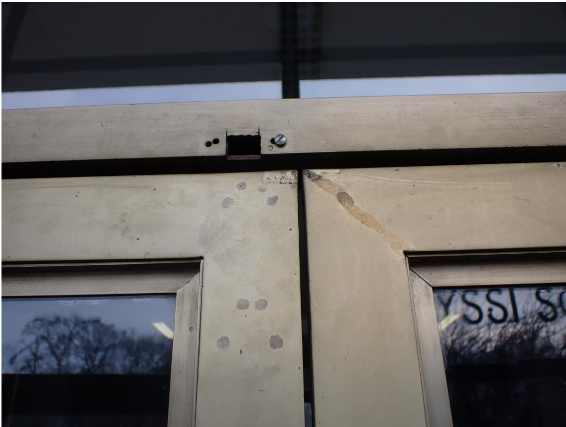
Pohled na původní dochované vnitřní dveře - letovaný spoj rámu z pakfonového profilu Pohled na výřez do jaklu pro zámek
