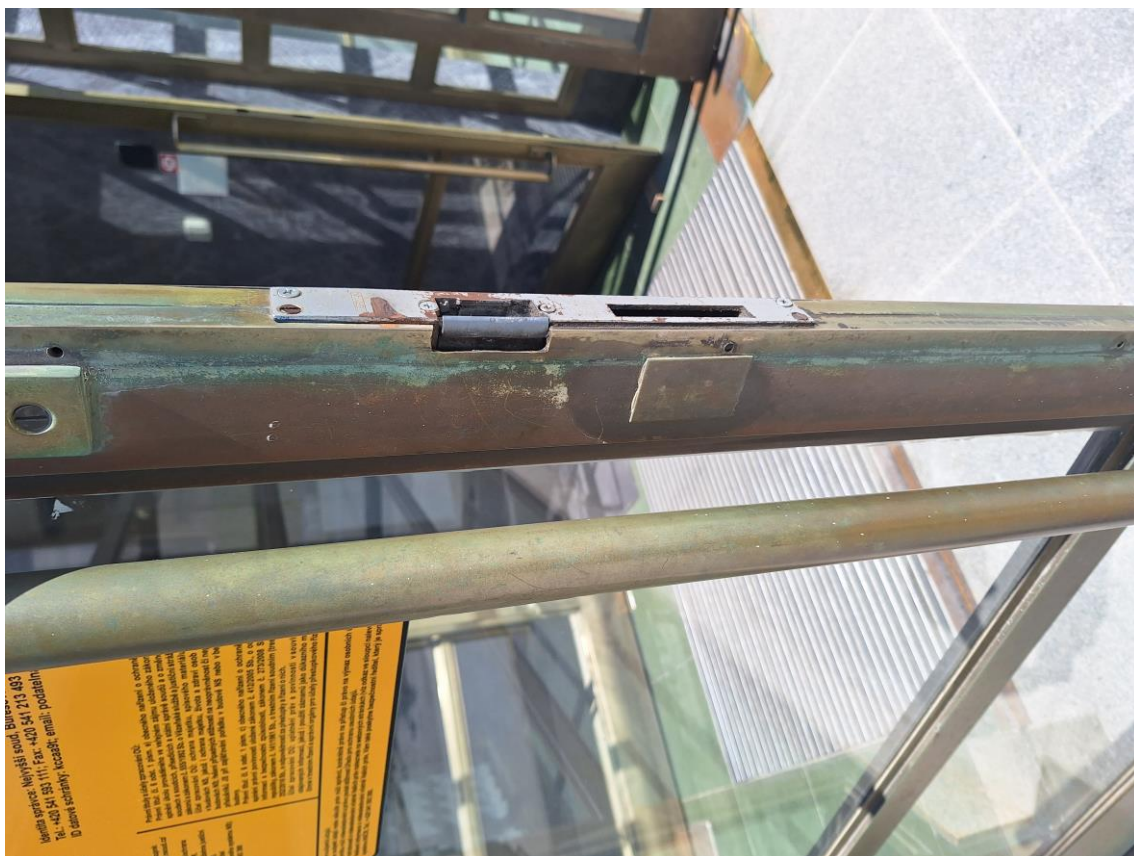
Osazení zámku, záplaty na obkladech, vrtané díry Spodní uložení křídla, svěšená část, použití nevhodných šroubů
