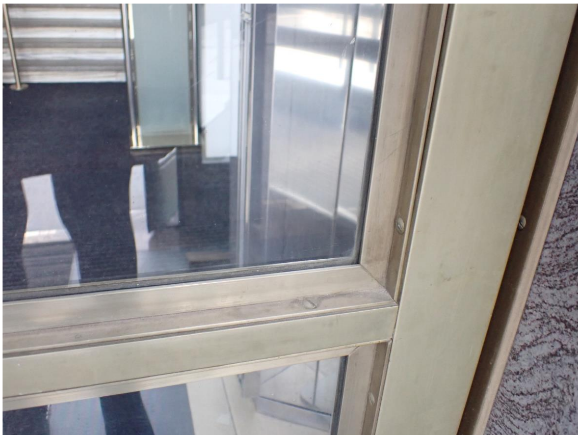
Pohled na původní dochované vnitřní dveře a způsob zasklení
