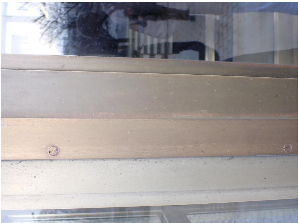
Dochovaná zástrč na vnitřních dveřích, tento typ navrhuji použít na vnějších křídlech Rozdílná barevnost – oxidace obkladu původního (světlejší) a novějšího (tmavší)
