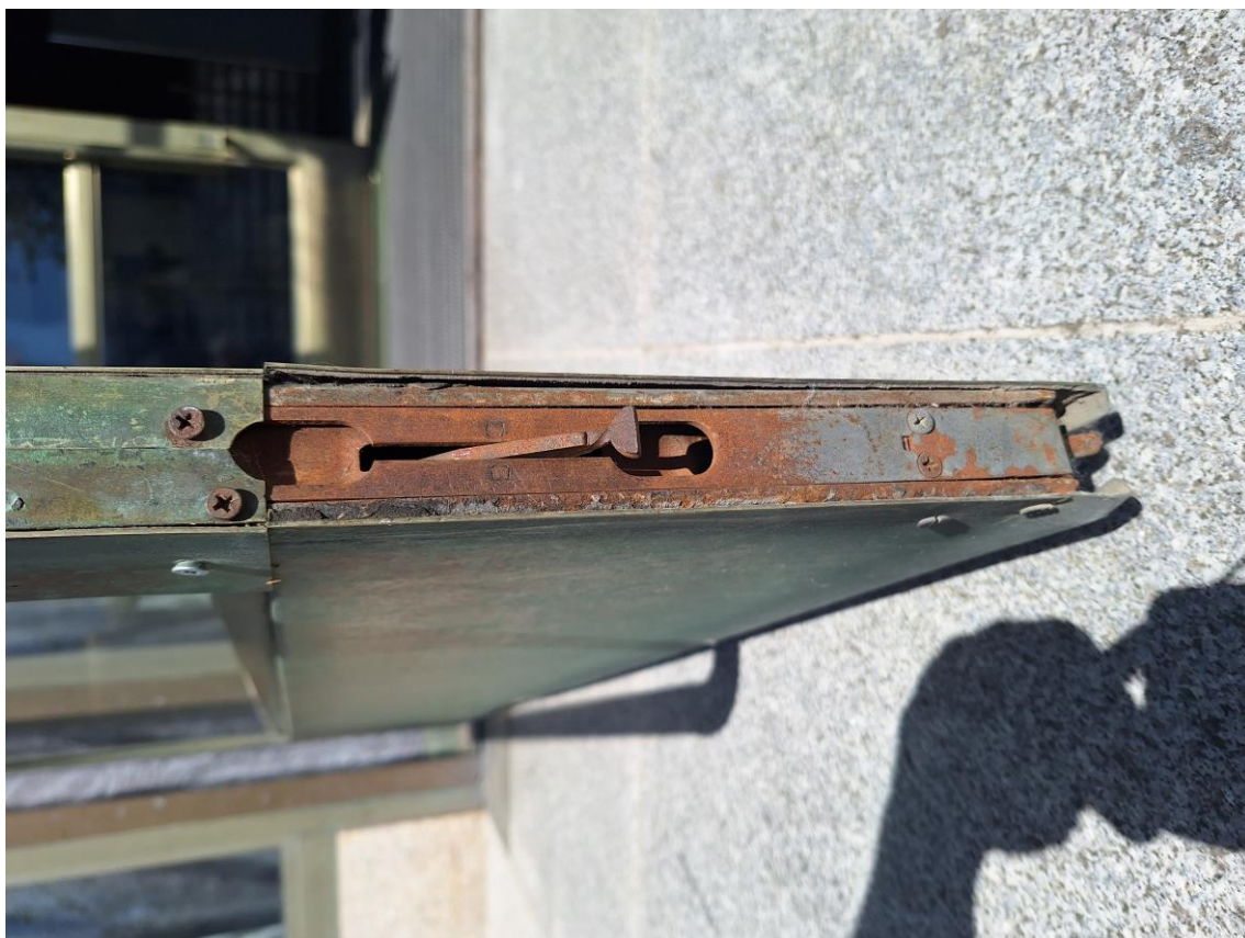
Nově osazený horní zavírač Assa Abloy bez pohonu, zatím funkční Poškozené zástrče v jaklovém rámu dveří
