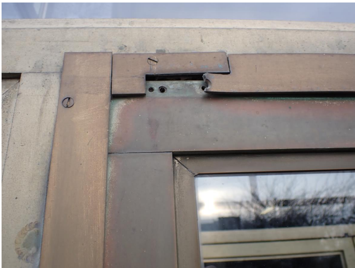
Levý roh -, poškozená MS klapačka křídla Střed dveří – mosazná klapačka, zoxidovaný povrch
