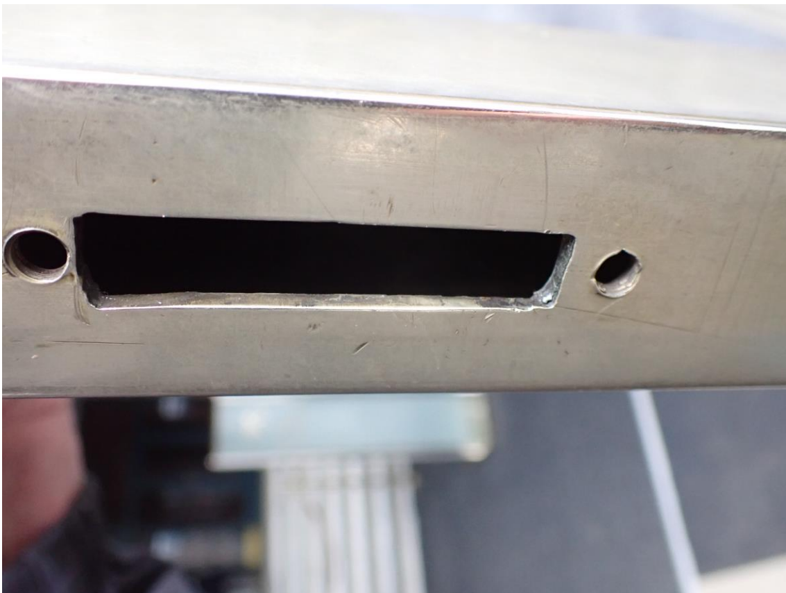
Pohled na původní dochované vnitřní dveře - letovaný spoj rámu z pakfonového profilu Pohled na výřez do jaklu pro zámek
