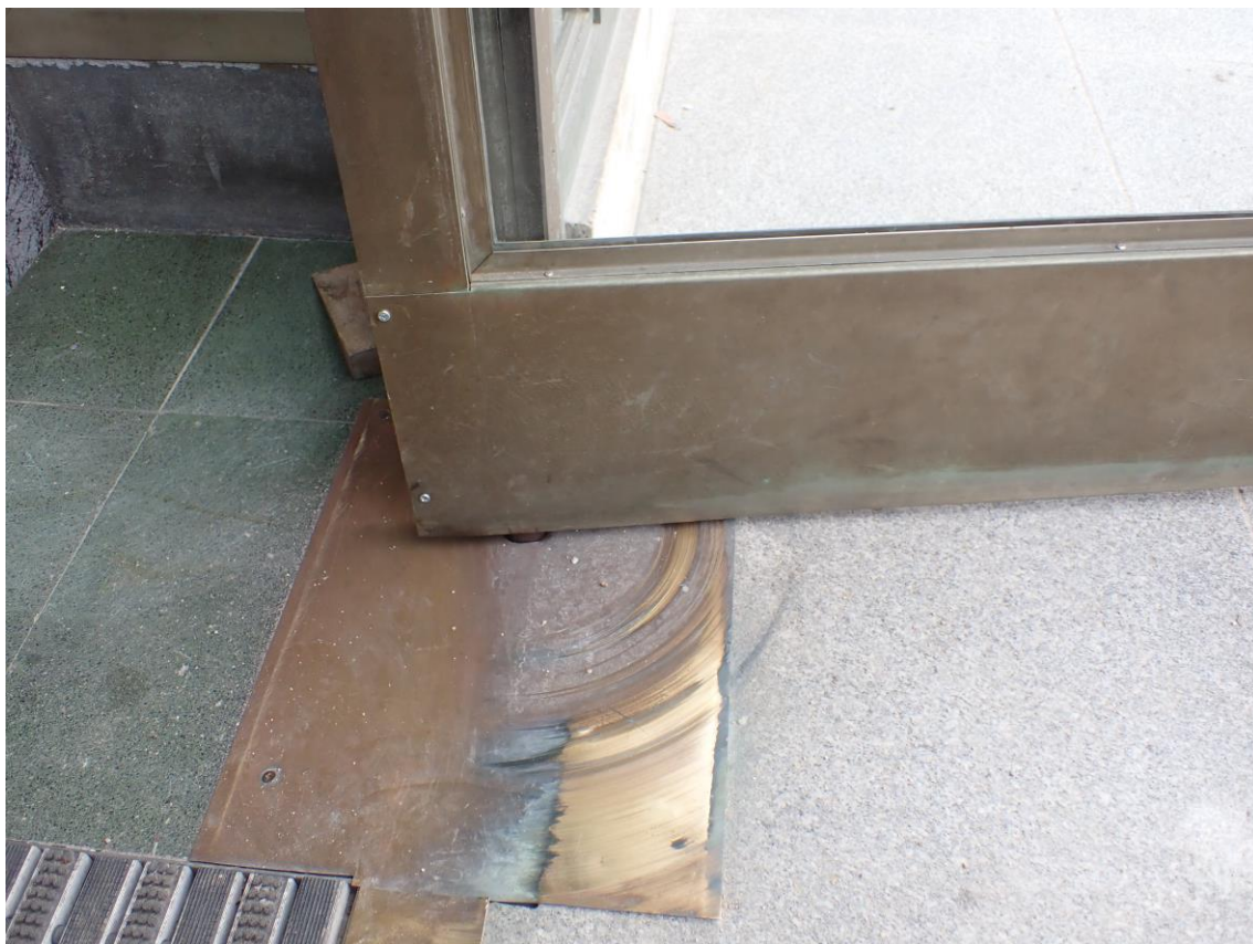
Osazení zámku, záplaty na obkladech, vrtané díry Spodní uložení křídla, svěšená část, použití nevhodných šroubů
