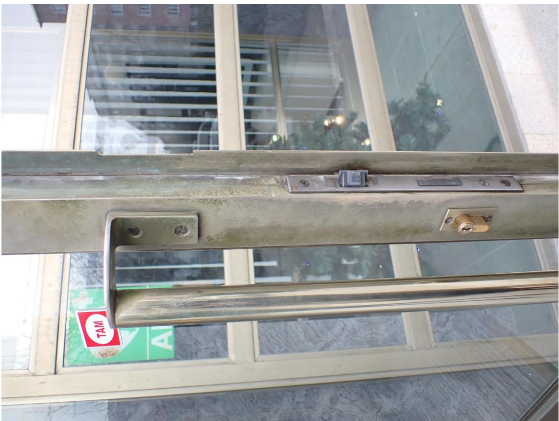
Zasklívací lišty na vnějších dveřích Pohled na uchycení madla a vyříznutou upravenou klapačku vnějších dveří
