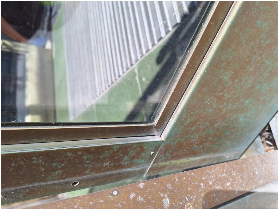
Zasklívací lišty na vnějších dveřích Pohled na uchycení madla a vyříznutou upravenou klapačku vnějších dveří
