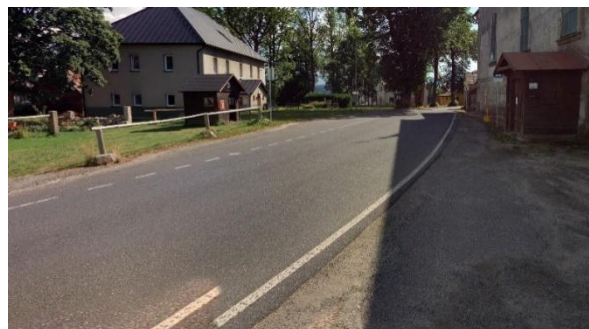
Silnice III/29018 Horní Polubný (úprava před kostelem)
