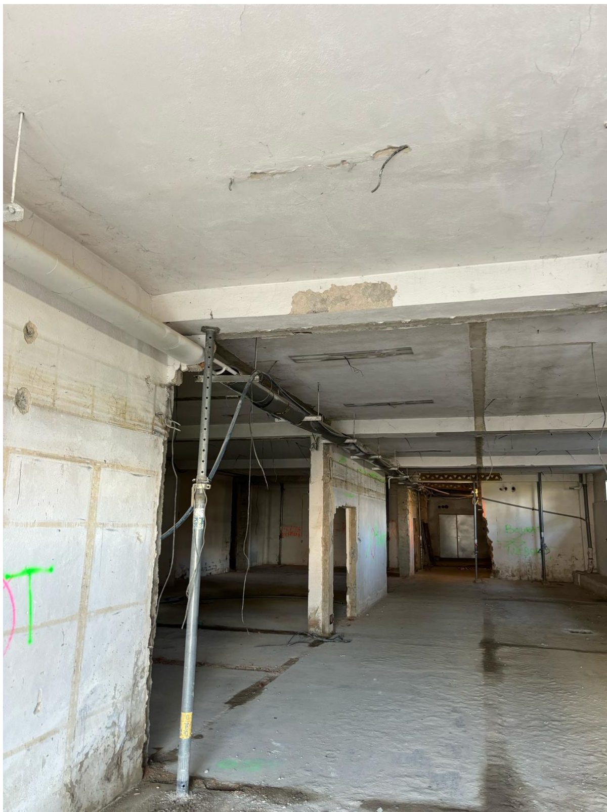
Monolitické stěny v ose 3-J/K a 3/L/M v objektu SO.01B, 1.PP
