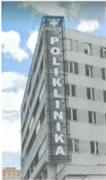
Obrázek 2 pohled na ocelovou konstrukci poutače
