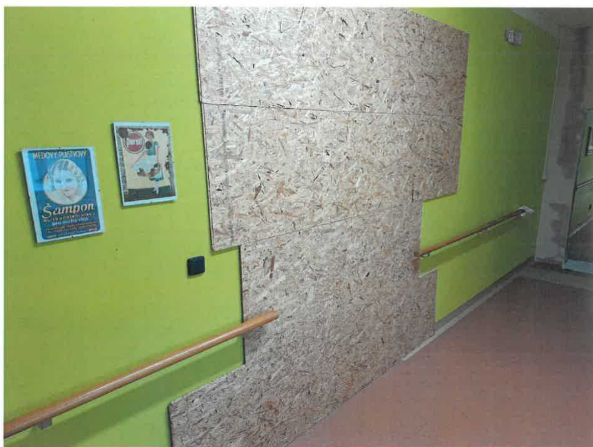
Obrázek 2: 2) Doplnění protipožárních dvířek na stávající rozvaděč
