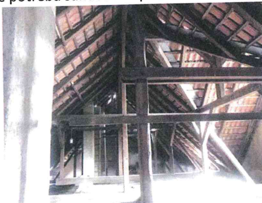
Obrázek 5: Pohled do krovu
