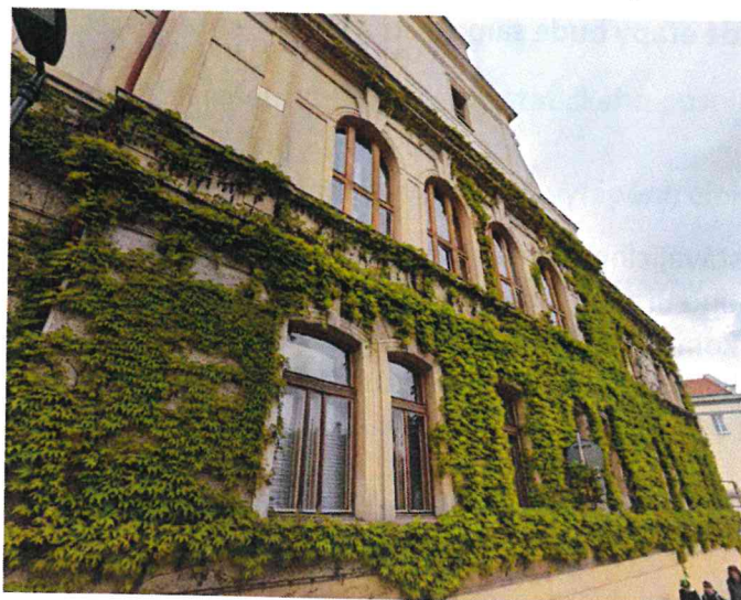
Obrázek 4: Východní průčelí budovy obrostlé přísavníkem trojlaločným
