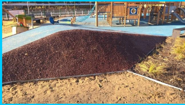
Ukázka realizace na nerovném terénu a svazích....
