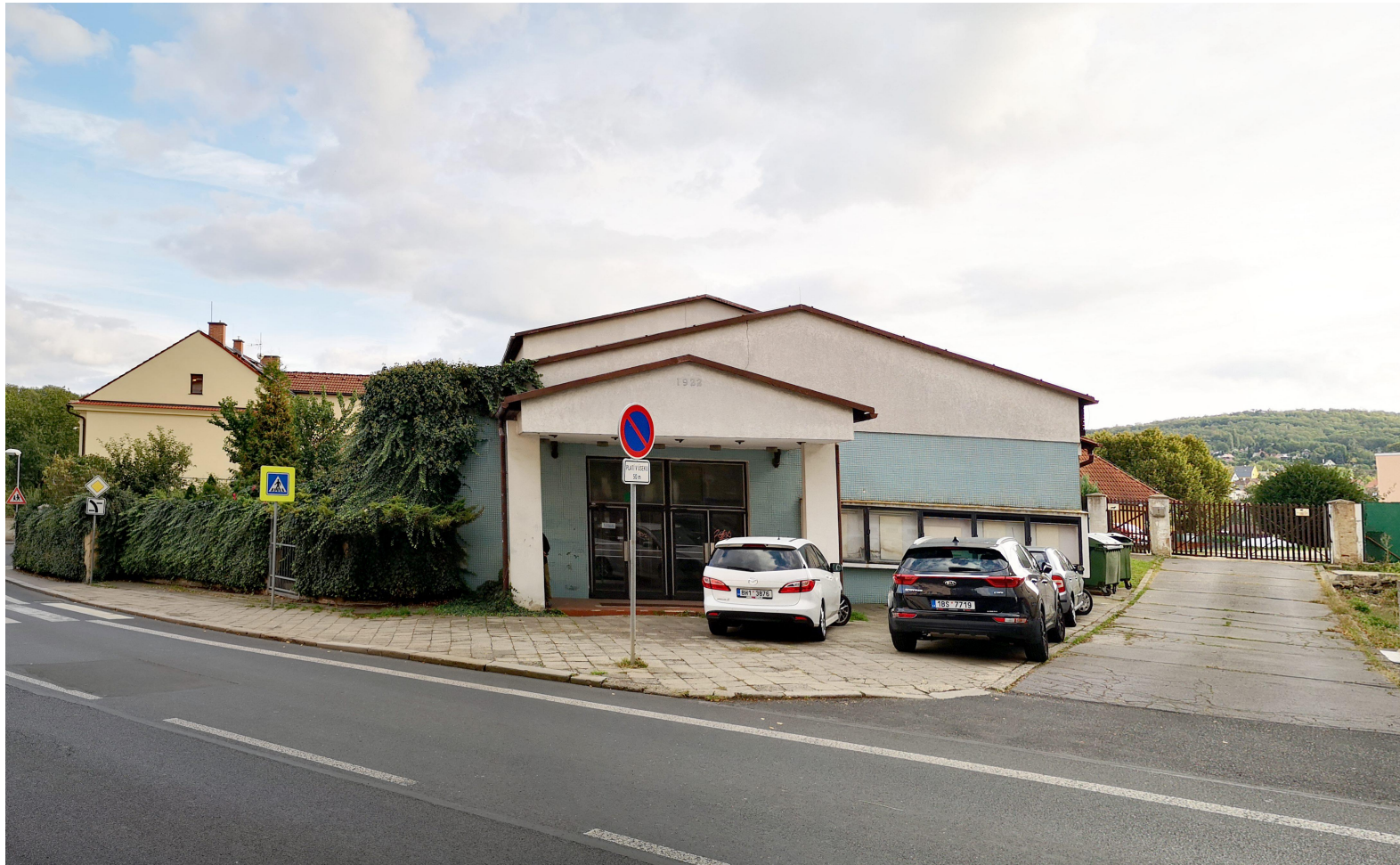
Pohled z ulice Mostecká
