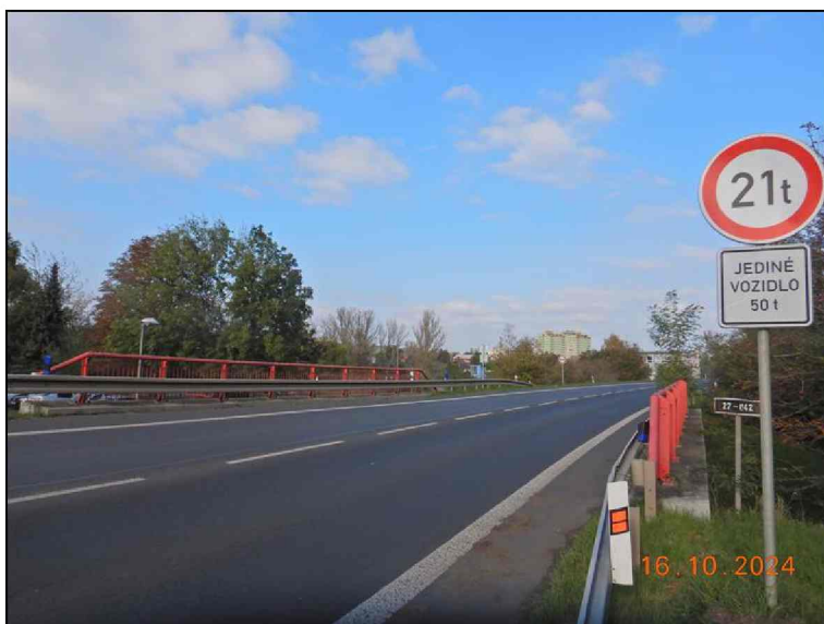
03_Pohled proti směru staničení.JPG
