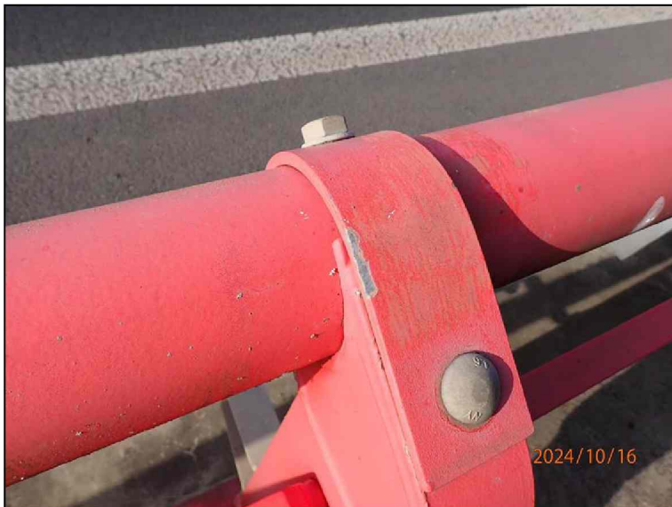
38_Zábradelní svodidlo vlevo.JPG
