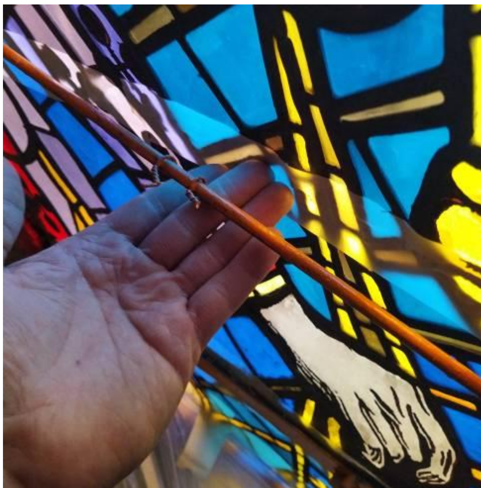
Výplň č.2 – důsledek hroucení se vitráže vlastní vahou – odtržení zavětrovacího železa od plochy vitráže
