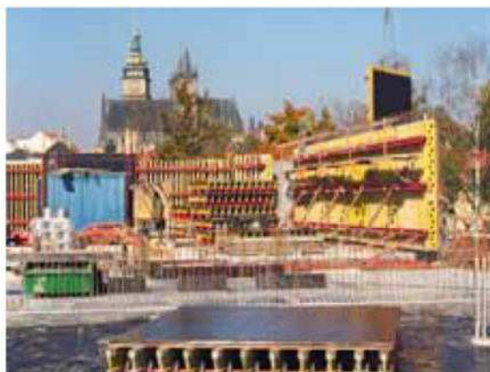
(25) Obr. F.4 – Nosníkové bednění
