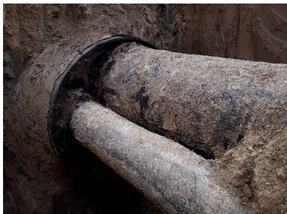
Obr.: ilustrační foto společných chrániček, které mohou být předmětem opravy
