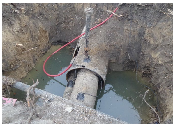
Obr.: ilustrační foto společných chrániček, které mohou být předmětem opravy
