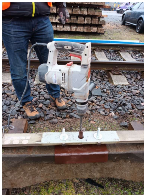
Obrázek 3 - Vrtání za použití přípravku
