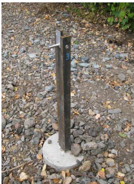
Obrázek 20 Otevřený profil konstrukce sloupku ŽPSV
