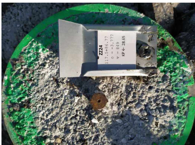
Obrázek 33 Roxor v betonovém bloku (základní odlehčená stabilizace)
