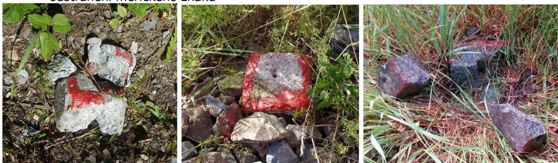
Obrázek 8 Ukázka zničených bodů sekáním trávy
