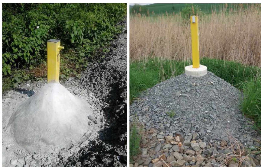
Obrázek 17 Řešení zhotovitele pro zvýšení stability zajišťovací značky
