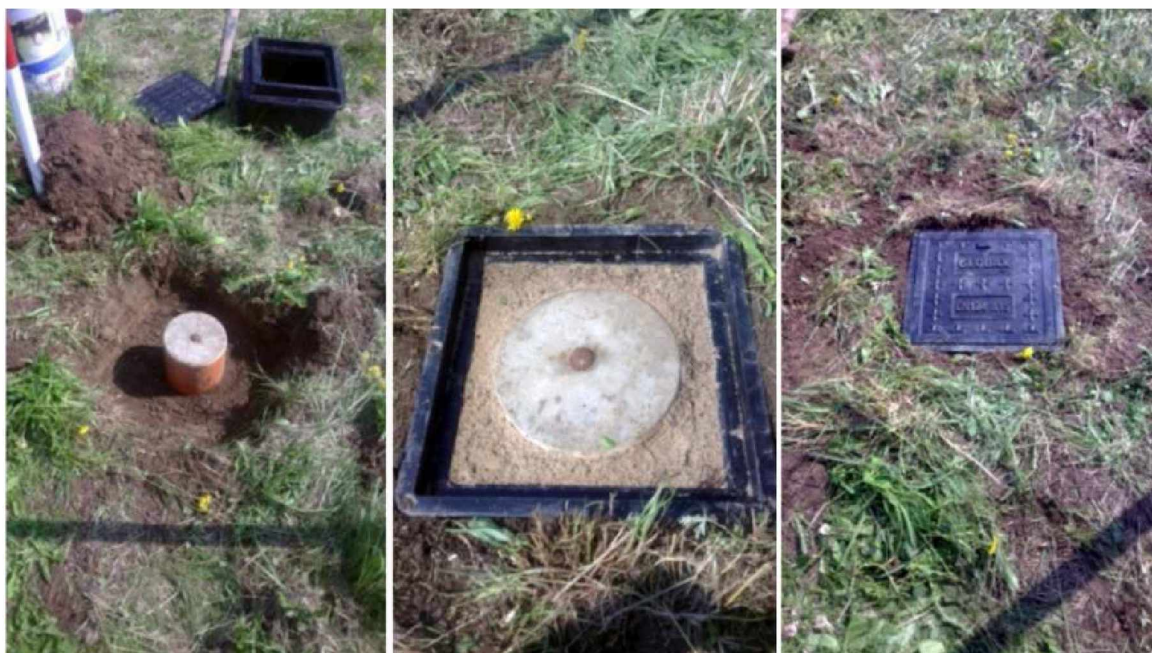
Obrázek 41 Příklad řešení plastové šachty hranaté
